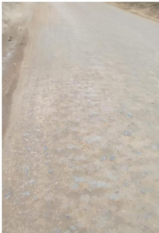
**Foto N°06:** Se evidencia el estado muy deplorable de la subrasante
