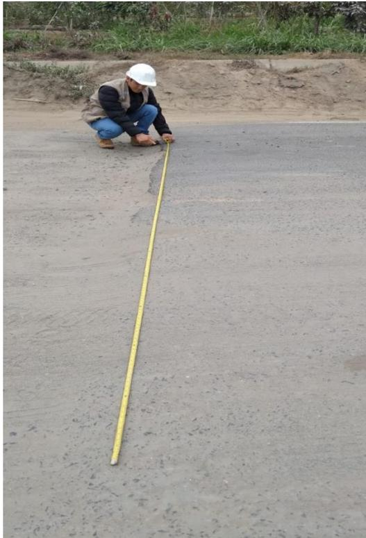
**Foto N°03:** El término del asfaltado y medición del ancho de la calzada
