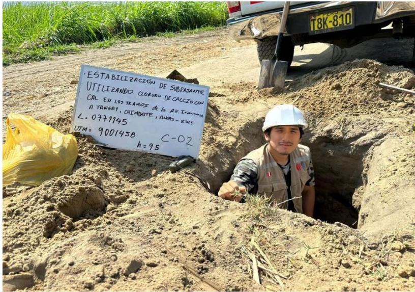
Foto N°17: Excavación y recolección del material de la C-02
