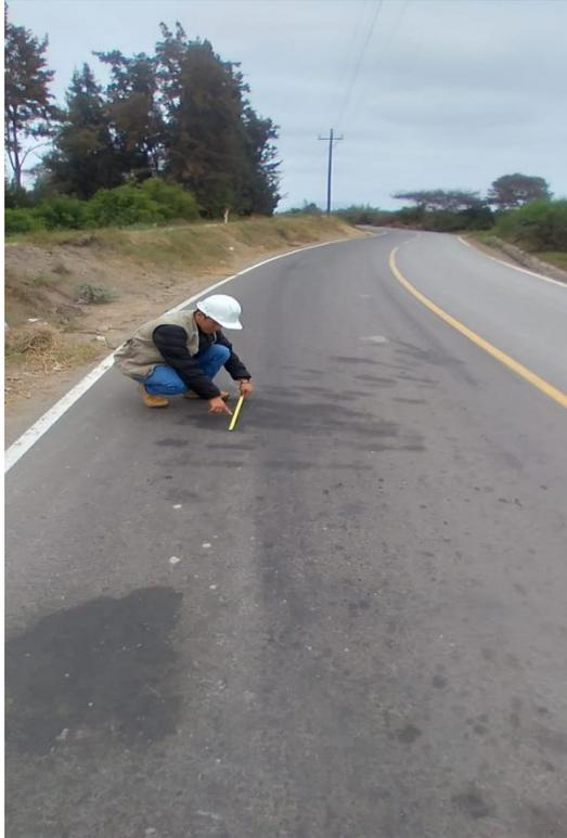
**Foto N°01:** Medir y observar la falla en la carpeta de rodadura
