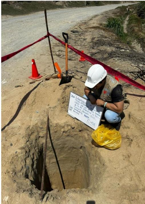
**Foto N°14:** Observación visual del cambio de color del suelo
