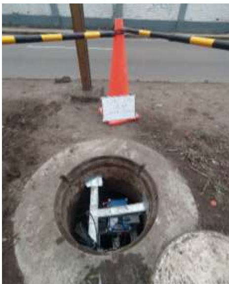
Imagen 10: Aforo 03 se ubica en la berma central de Av. Cesar Vallejo, frente Hospital Hipólito Unanue
