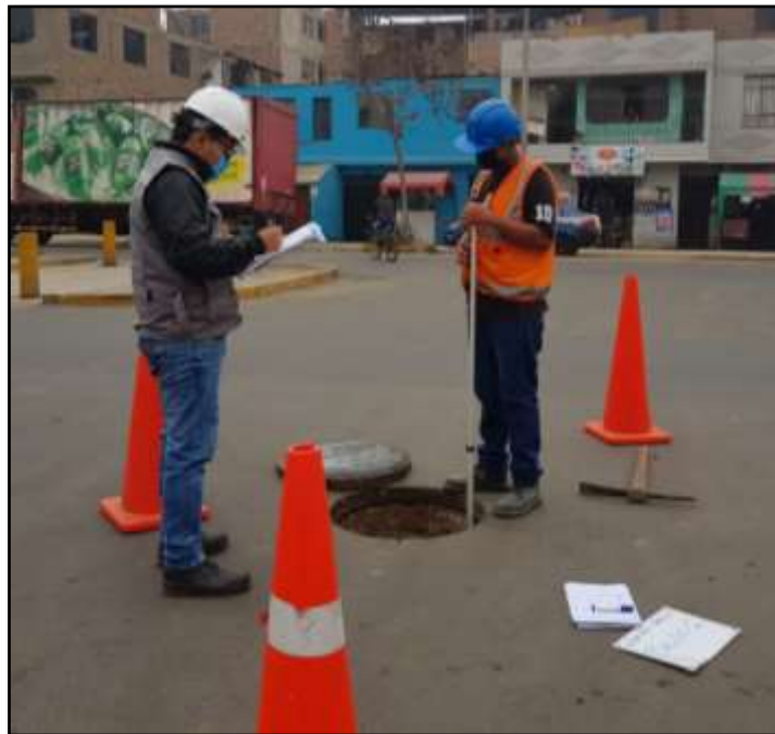
Imagen 04. Aireación de gases en los buzones
