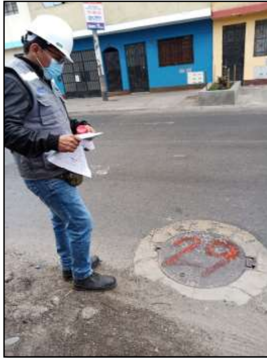
Imagen 01. Pintado de tapas de buzones con spray
