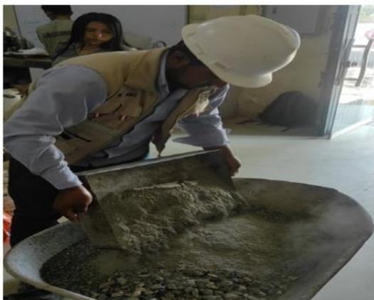
Ilustración 11. Incorporación de los materiales previo a mezclar
