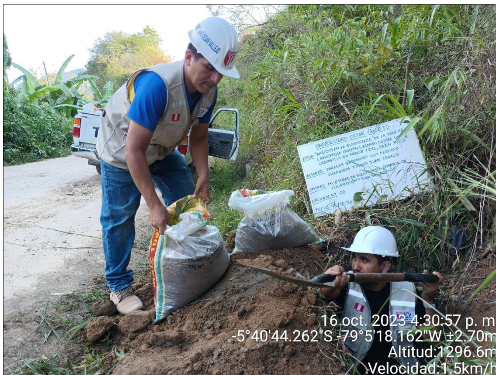
Figura 24. Muestreo para CBR de la calicata N° 06
