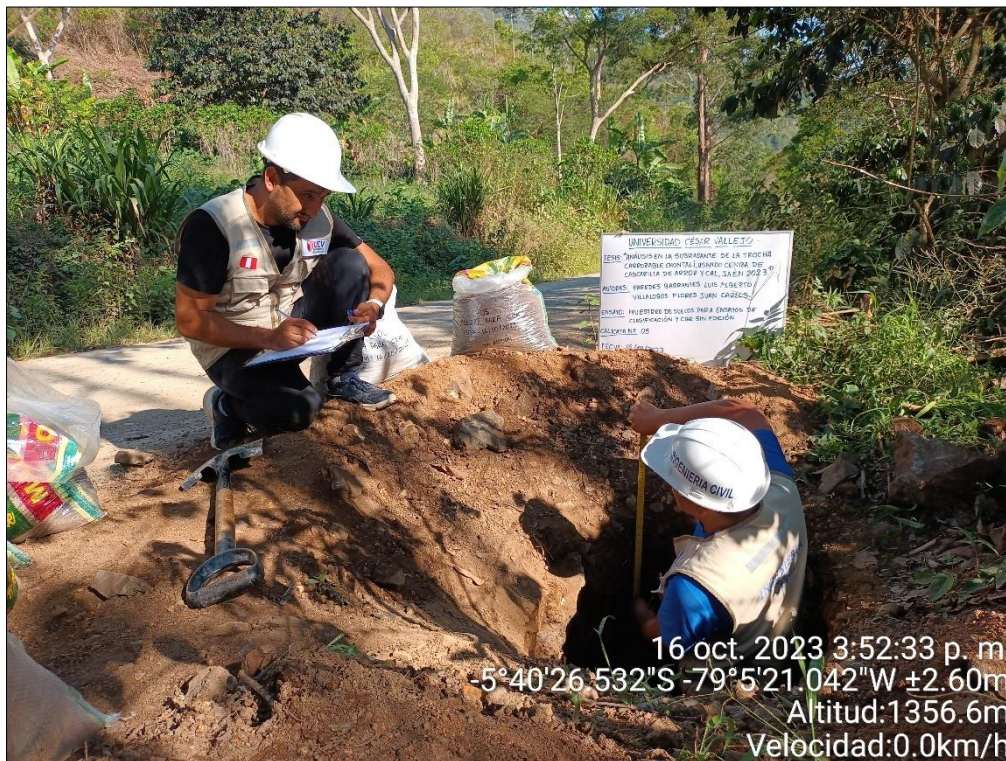
Figura 24. Muestreo para CBR de la calicata N° 06
