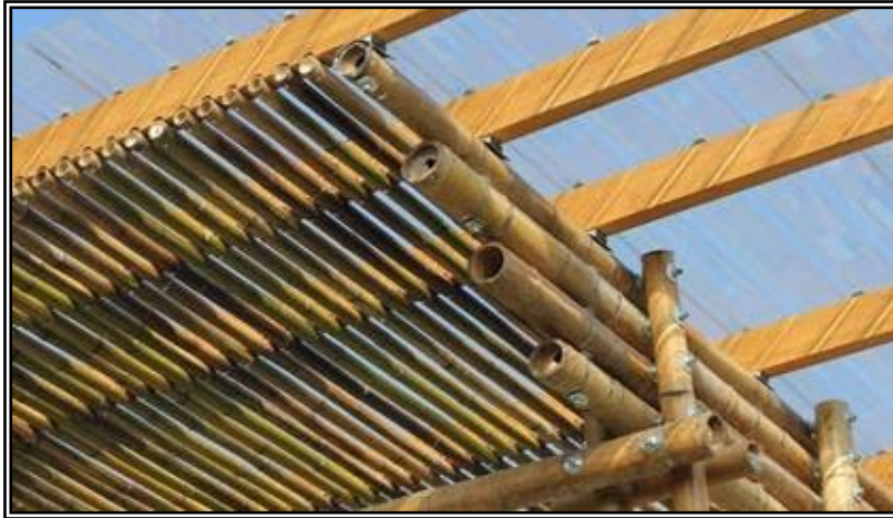
Figura 34. Tipo de unión de vigas, de 2 secciones
