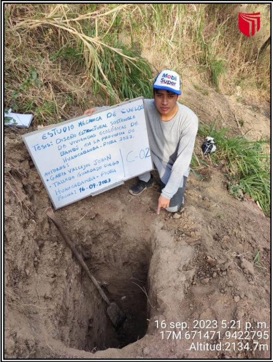
Anexo 03: Panel fotográfico de la Calicata 02.
