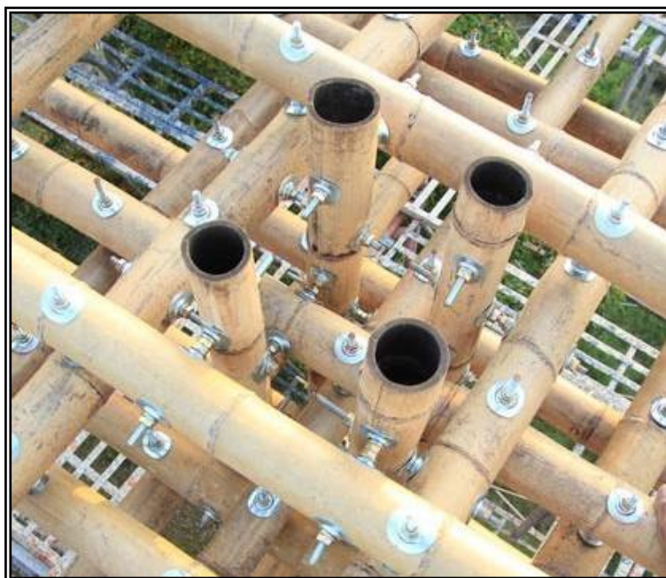
Figura 19. Juntas integradas enchufable por tornillo
