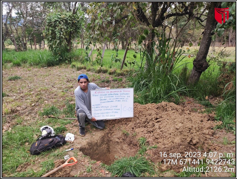
Anexo 02: Panel fotográfico de la Calicata 01.
