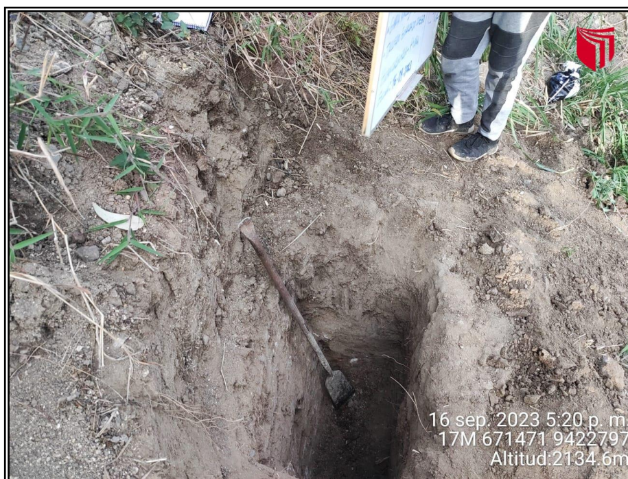
Figura 10. Estratos del suelo se realizará la estructura.
