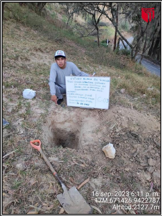
Anexo 03: Panel fotográfico de la Calicata 03.
