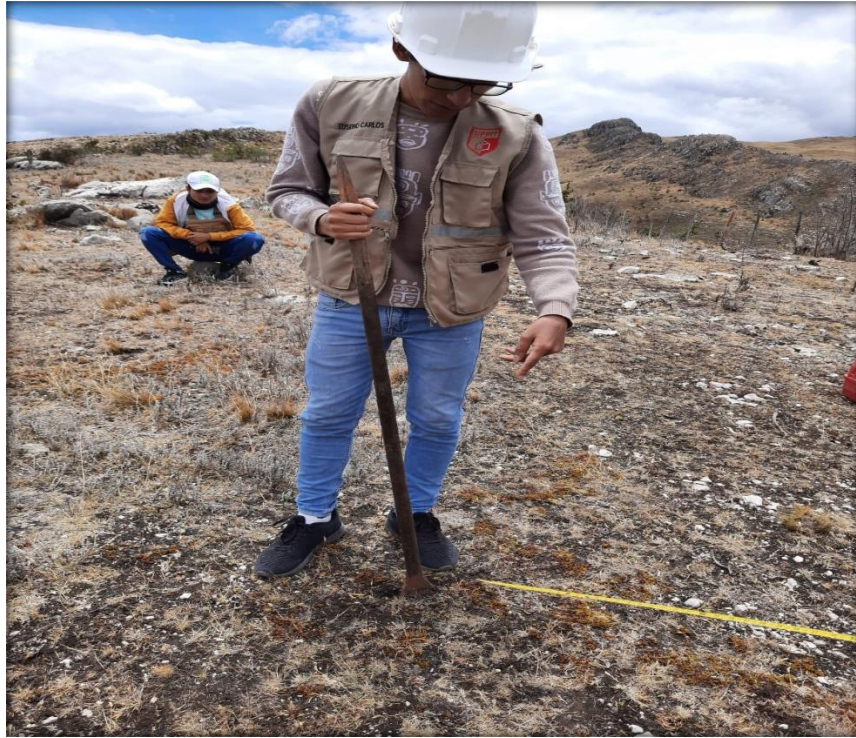
MEDICIÓN PARA EXCAVACIÓN DE CALICATAS.
