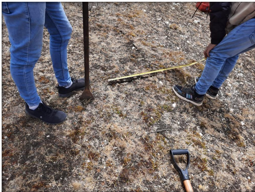
MEDICIÓN PARA EXCAVACIÓN DE CALICATAS.
