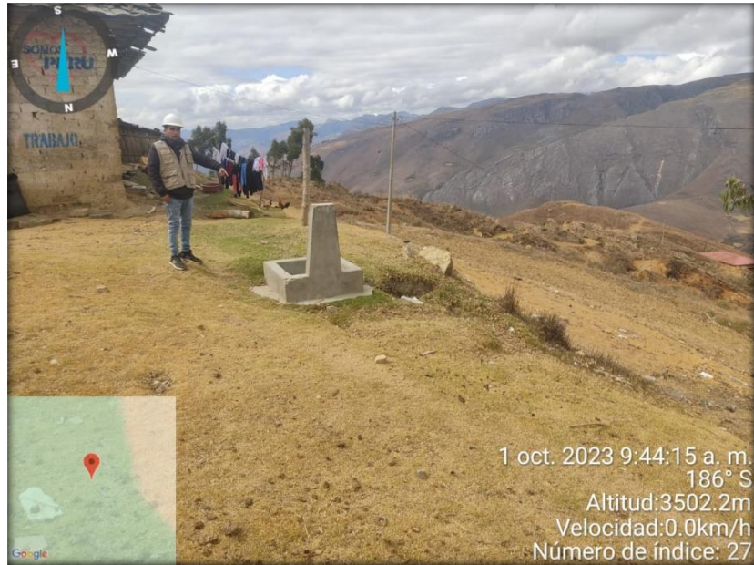
PRESENCIA DE PILETAS DE ABASTECIMIENTO DE AGUA PARA LA COMUNIDAD DE HUAYLLAMBABA
