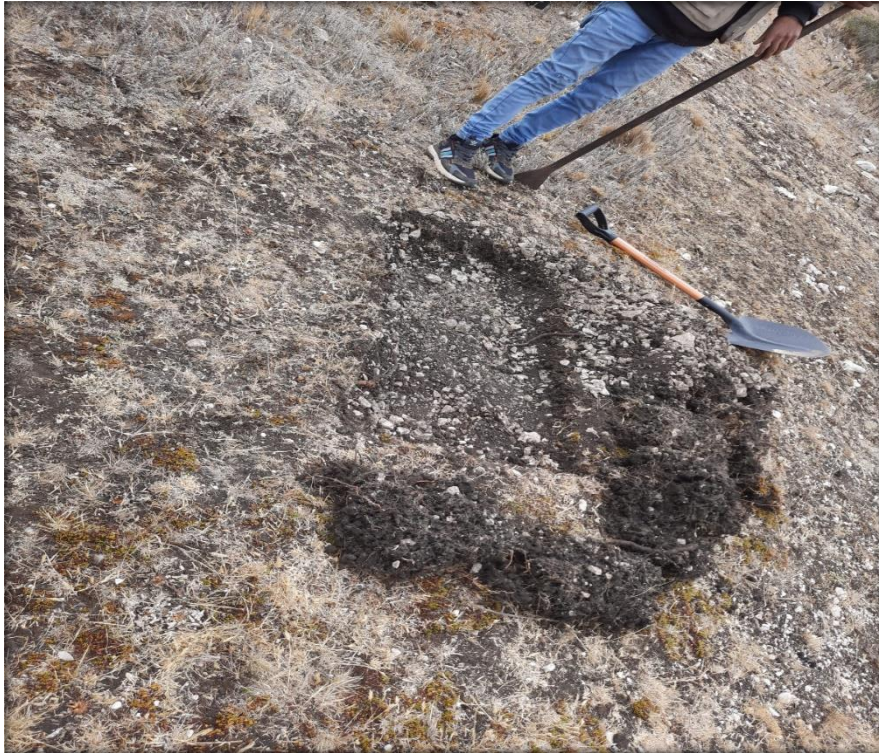
PROCESO DE EXCAVACIÓN PARA CALICATAS.
