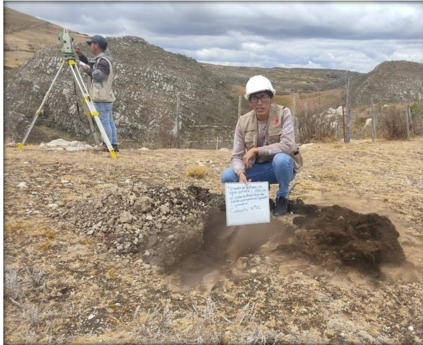
SE APRECIA LA PROFUNDIDAD DE LA EXCAVACIÓN DE CALICATA
