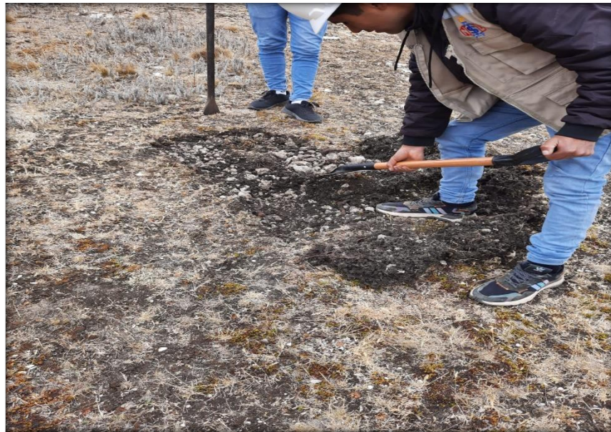
PROCESO CONSTRUCTIVO DE EXCAVACIÓN PARA CALICATAS
