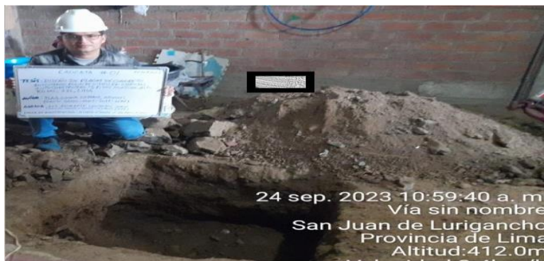
Figura 18. Perforación de calicata.
