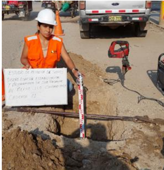
Figura 22 Excavación de calicatas a 1.5m de profundidad
