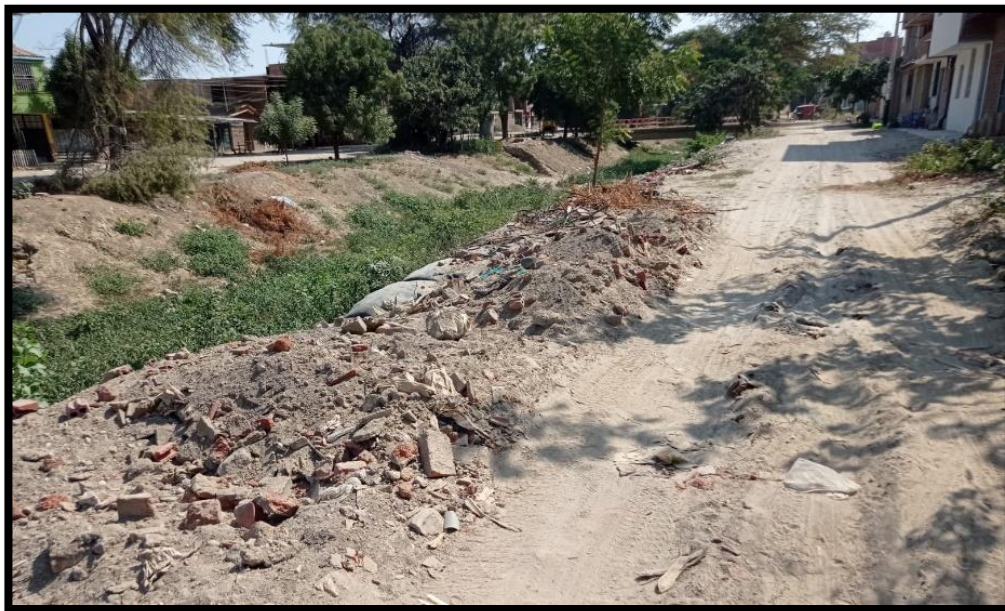
Figura N°15 y N°16 Fotografías de las Calle S/N cerca al canal
