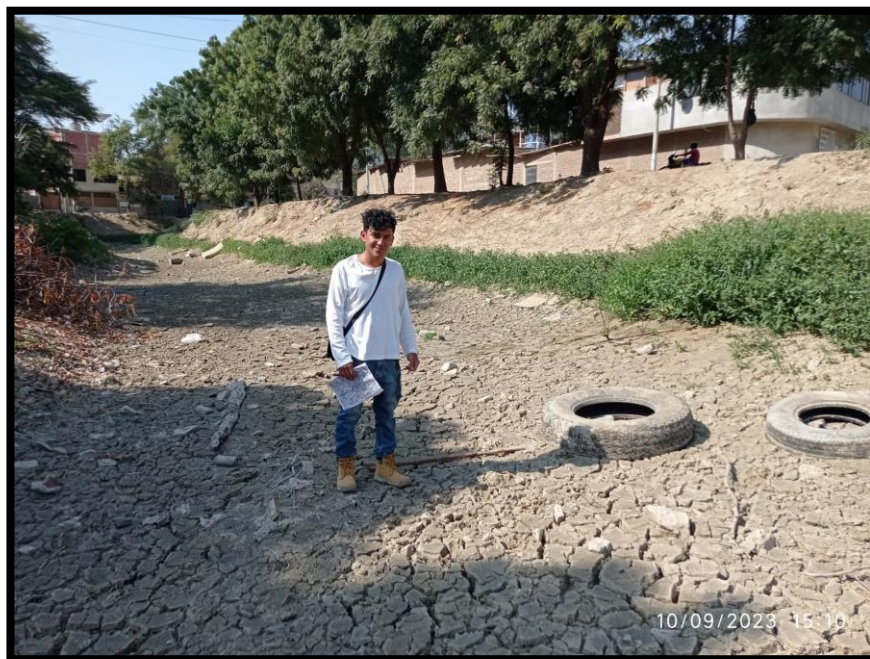
Figura N°10 Fotografía del Canal 1308 estado actual
