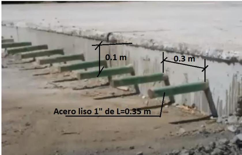
Figura 76. Colocación de Dowells.
