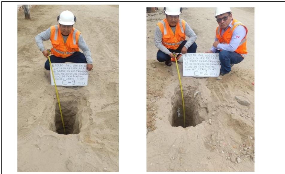
Figura 14. Excavación de las calicatas a 1.5m de profundidad.
