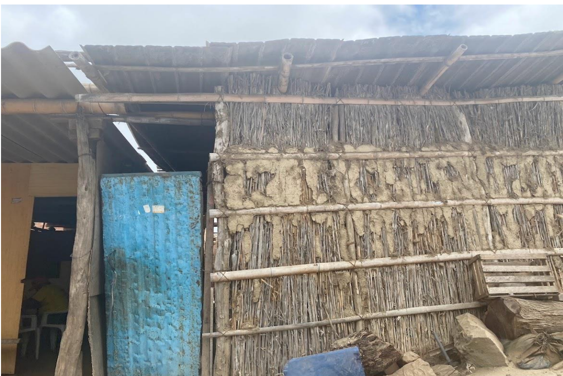
Figura - 12 Vivienda del sector sur del Caserío Narihuala
