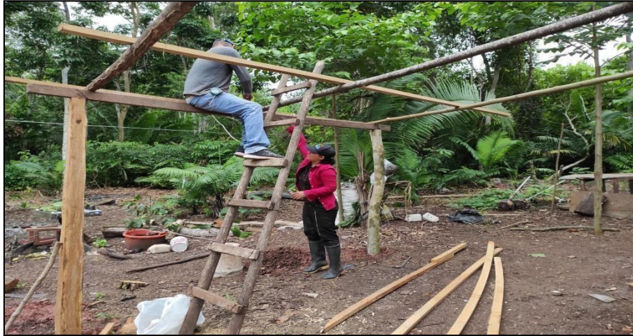
Construcción de la infraestructura
