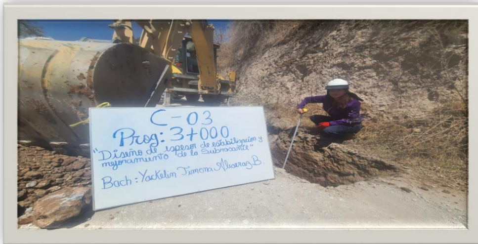
Figura 19. Calicata en situ C-01, C-02, C-03
