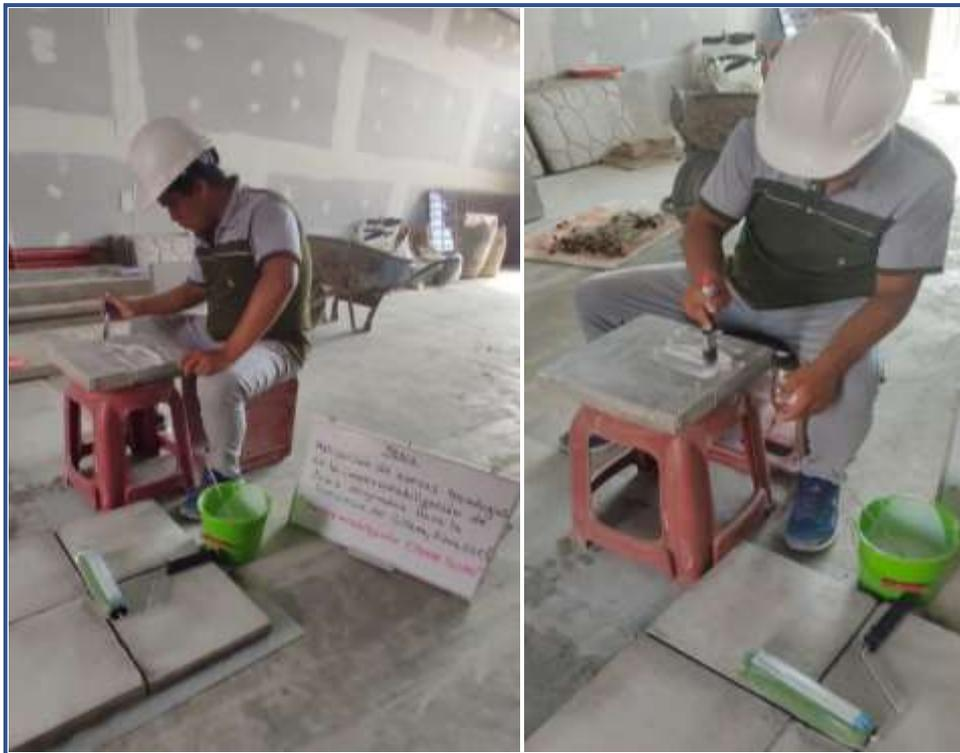
Figura 2. Impermeabilización con Sikafill Techo-3
