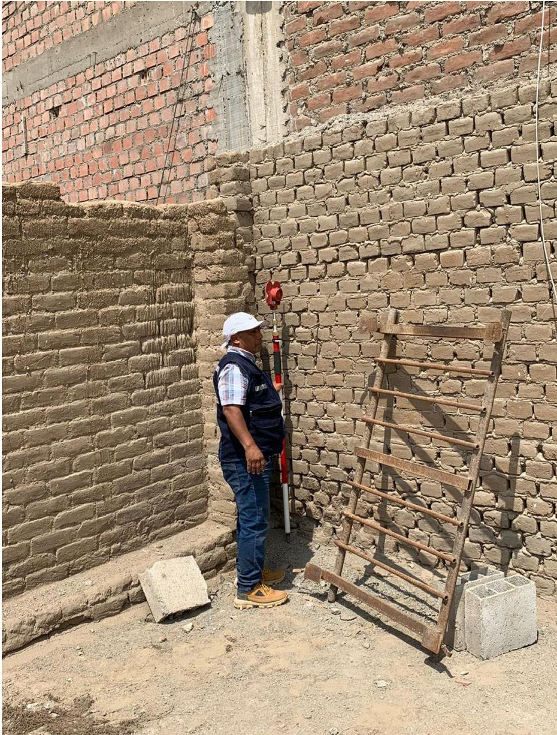
Nota: En la imagen se observa al trabajador sosteniendo el prisma para que el topógrafo logre medir los datos necesarios para el proyecto con la ayuda de la estación total.
