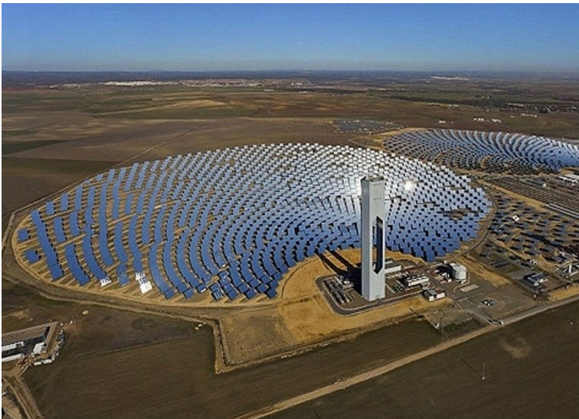
Figura 12 Primera central térmica solar comercial de torre central y campo de heliostatos instalada en el mundo. Sevilla.
