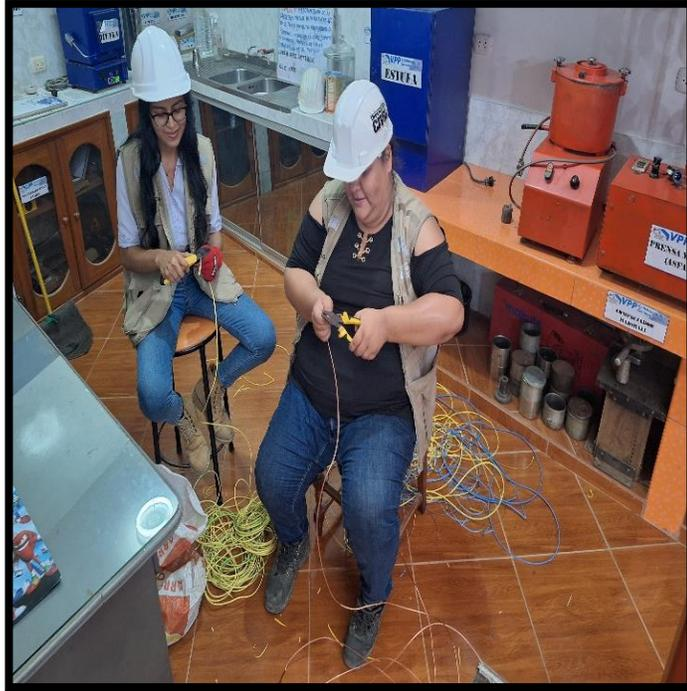
**Figura B:** Corte de los filamentos de cobre a una medida de 7 cm.
