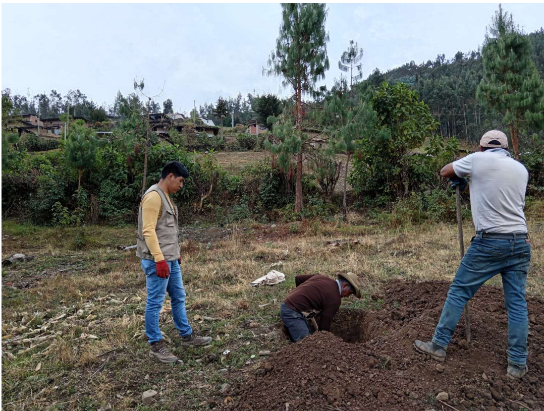
Foto N° 03: Como se observa en la figura, excavación manual de la calicata.
