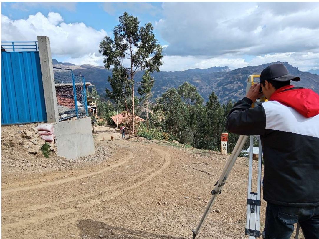
Foto N° 11: Se observa en la imagen el levantamiento topográfico.
