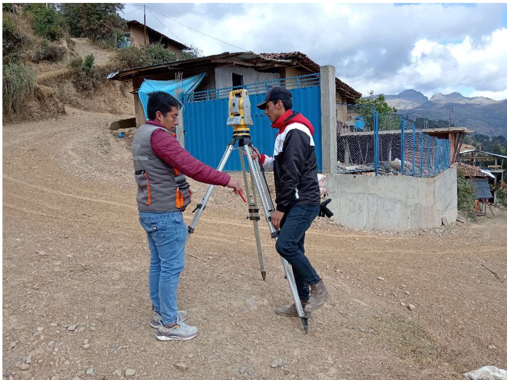
Foto N° 05: Se aprecia en la foto al topógrafo dando indicaciones al tesista como estacionar y nivelar a estación total.
