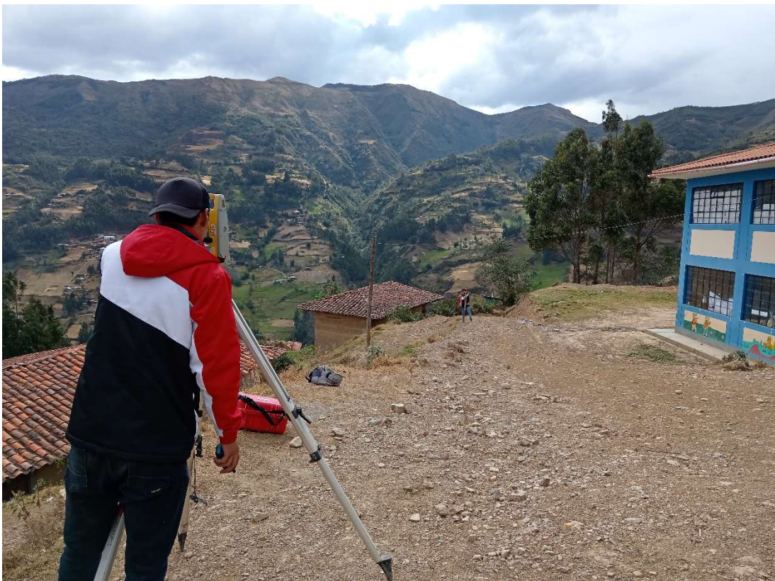
Foto N° 09: Se observa en la imagen el levantamiento topográfico.
