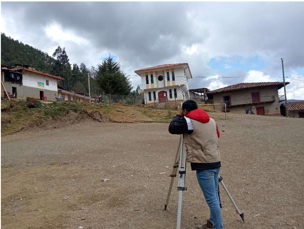
Foto N° 19: Se observa en la imagen a los tesistas realizando el levantamiento.
