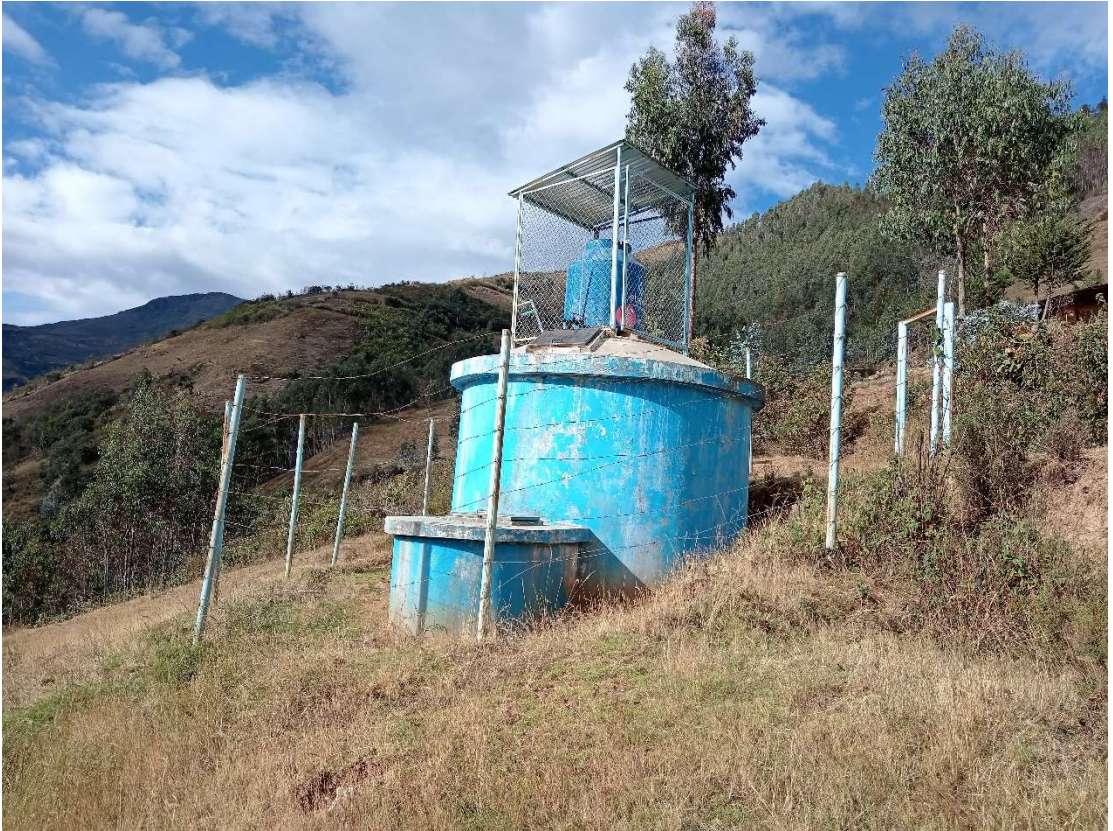
Foto N° 26: Se observa en la imagen el reservorio actual de la localidad de Rago.
