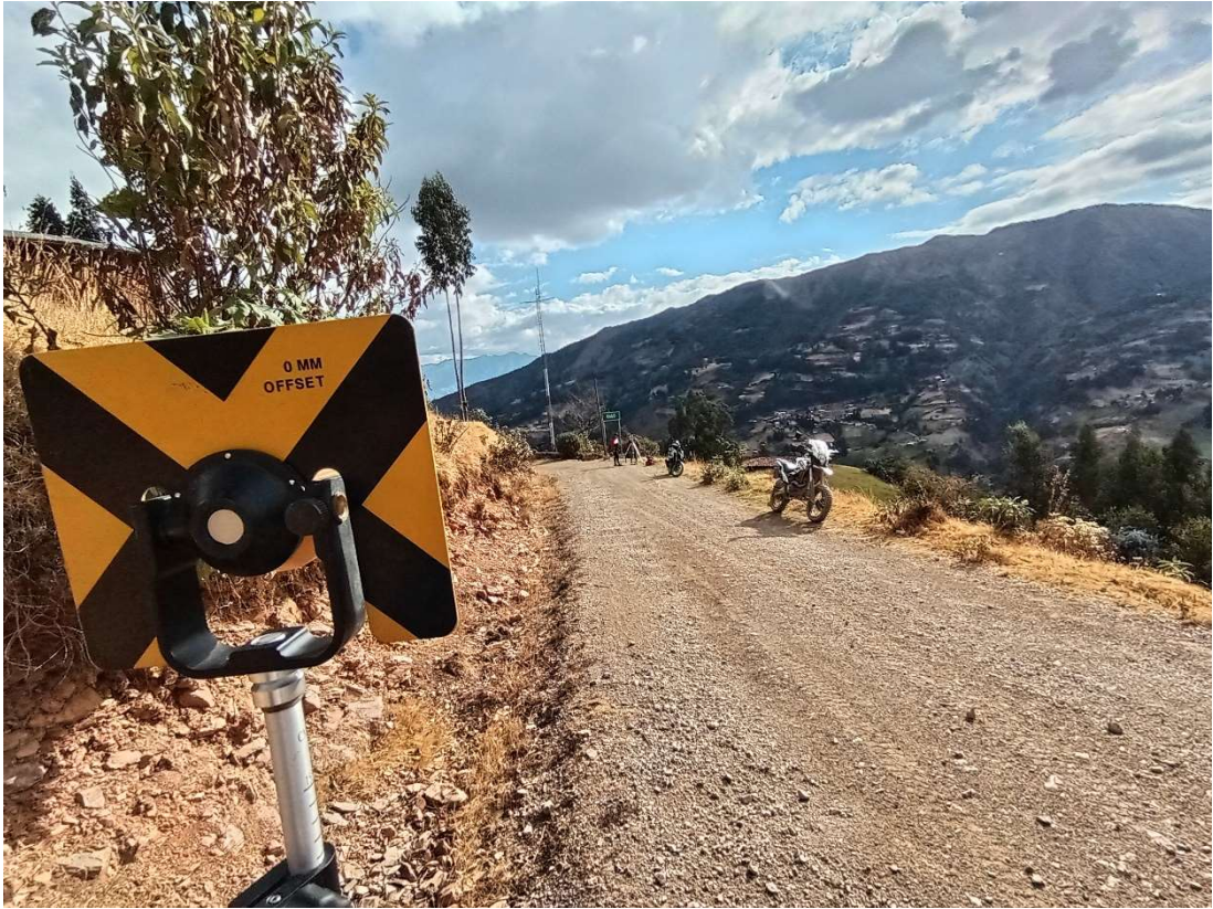
Foto N° 24: Se observa en la imagen realizando el levantamiento de la trocha carrozable.
