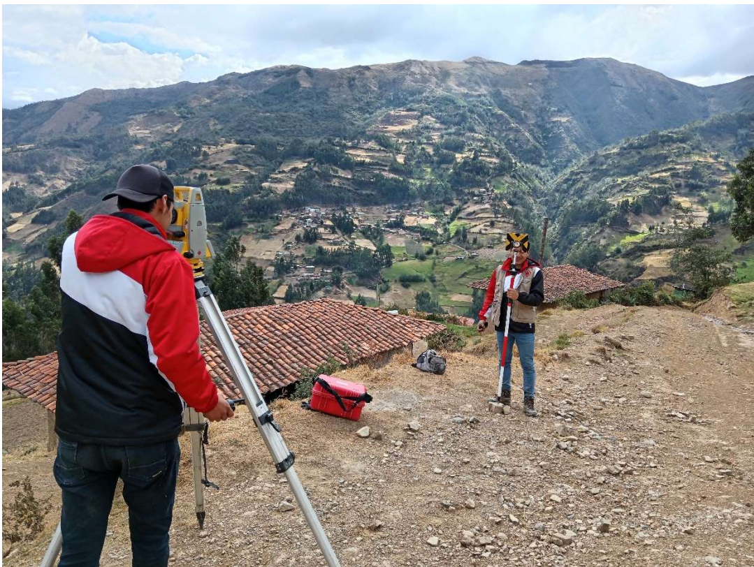
Foto N° 07: Se observa en la imagen tomando referencia del BM01.
