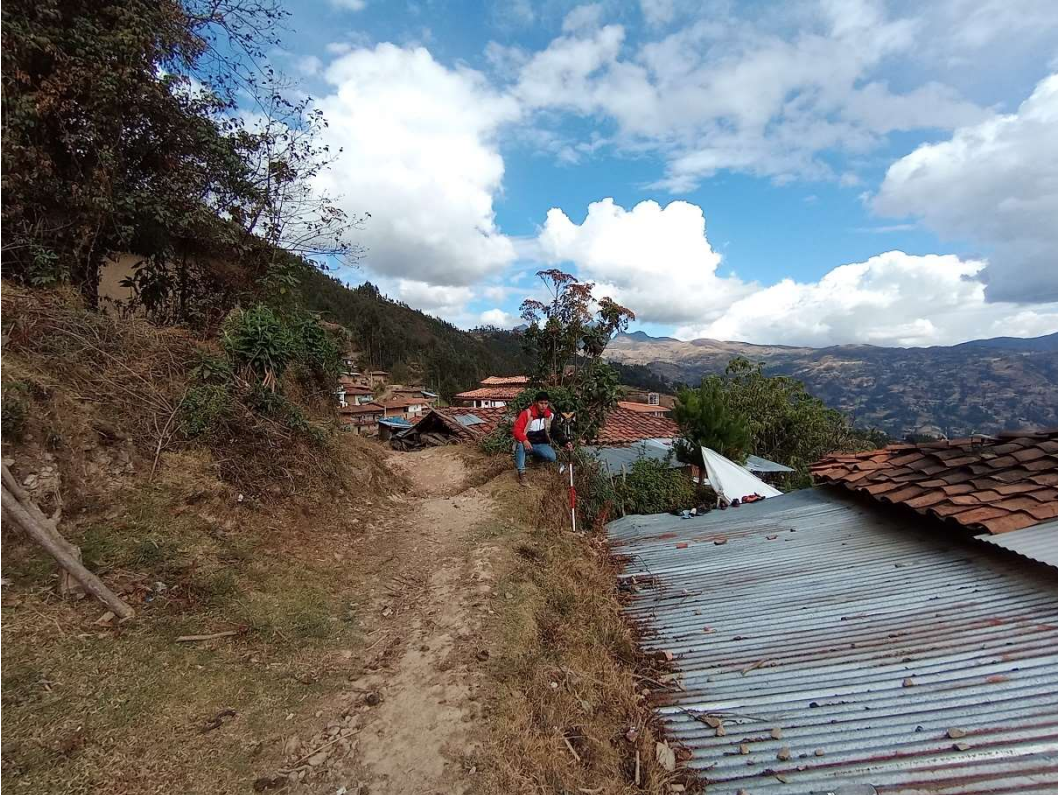
Foto N° 13: Se observa en la imagen el tesista prismando para el levantamiento topográfico.
