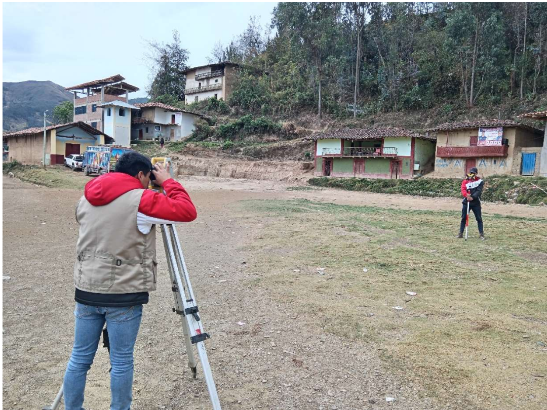
Foto N° 16: Se observa en la imagen a los tesistas tomando punto de referencia para el BM.
