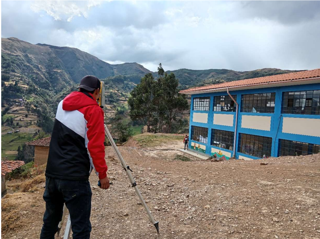
Foto N° 08: Se observa en la imagen el inicio del levantamiento topográfico.
