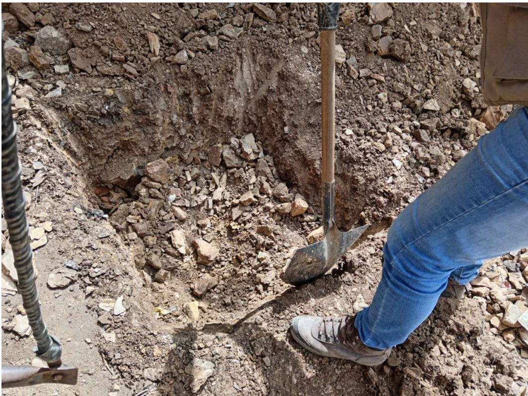
Foto N° 13: Se aprecia en la foto excavación manual de calicata 05.
