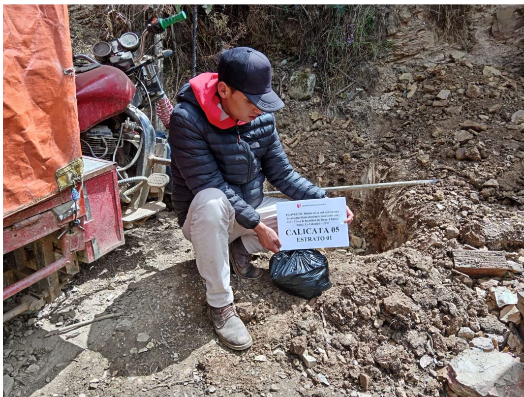
Foto N° 15: Se aprecia en la foto toma de muestra de la calicata.
