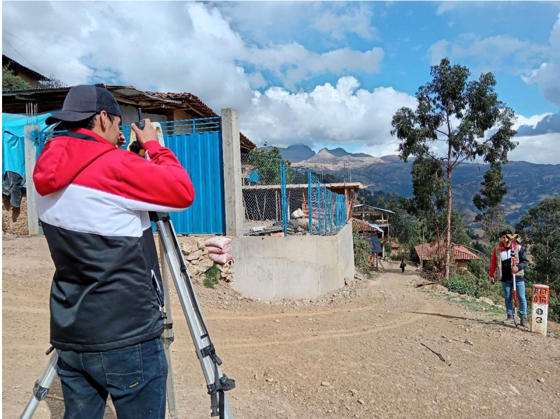
Foto N° 10: Se observa en la imagen el levantamiento topográfico de la trocha carrozable.
