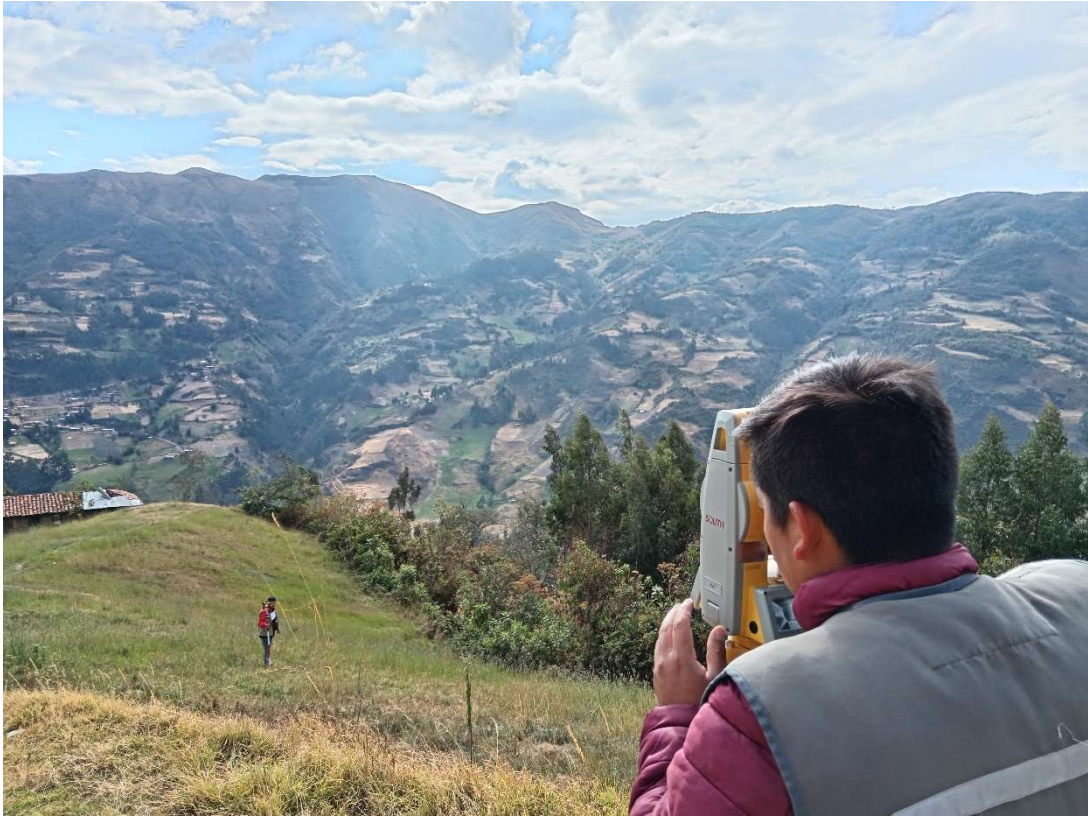
Foto N° 22: Se observa en la imagen al topógrafo realizar el levantamiento.
