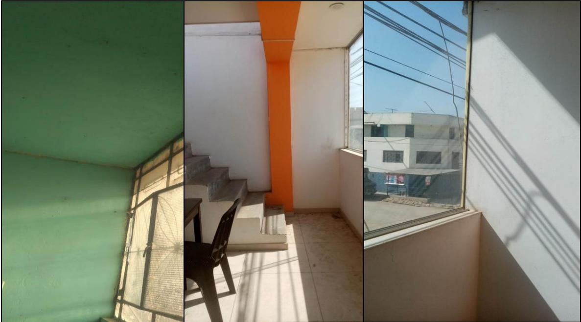
*Nota.* En la figura 42 se observa el ingreso de radiación solar de afuera hacia el exterior, se observa una vivienda con los acabados inadecuados de baja resistencia térmica logrando un confort térmico inadecuado.
