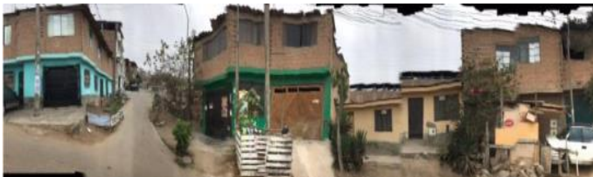
Perfil urbano de la avenida Ascope
