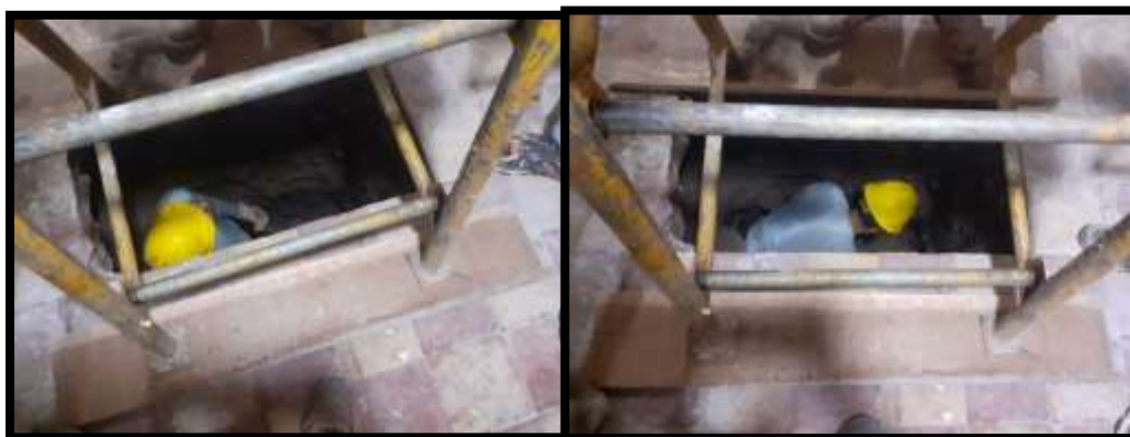
Figura 30. Proceso de excavación para la calicata Fuente: elaboración propia
