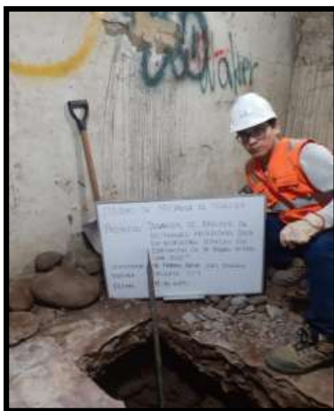
Figura 31. Muestra de profundidad de excavación para la calicata Fuente: elaboración propia
