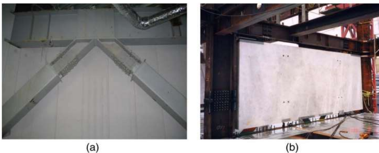
Figura 3. Configuración de arriostamiento de pandeo restringido reales (a) BRB de tubo típico y (b) BRB de panel
