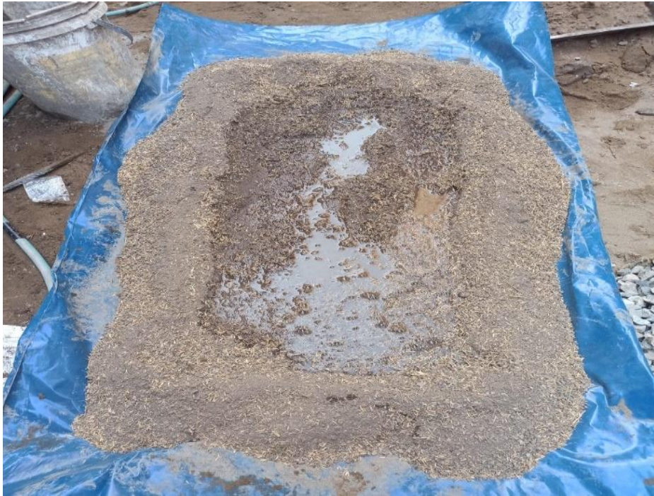
FIGURA 5: mezcla de barro
