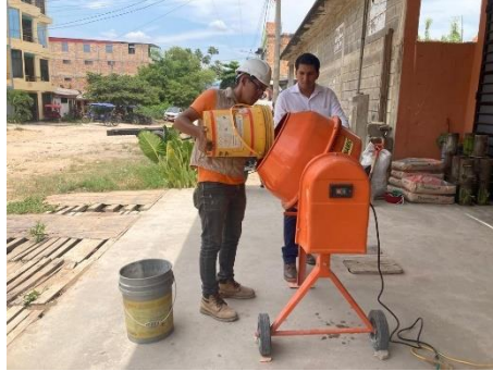
Figura 17: Mezcla de los agregados
