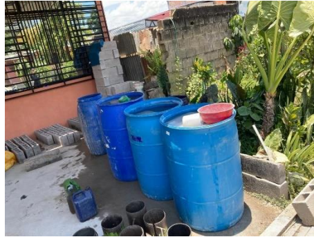
Figura 26: Concreto curado a 14 días
