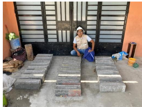
Figura 24: Curado del concreto
