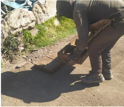
Figura 19: Moldeado de ladrillo
