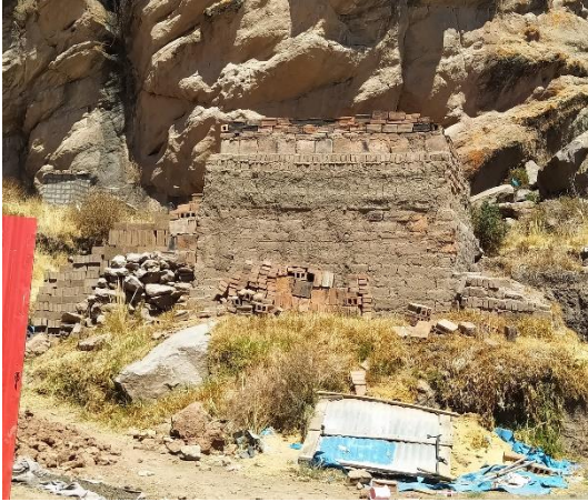
Figura 25: Horneado de ladrillo
