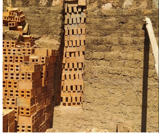
Figura 26: Enfriado del ladrillo
