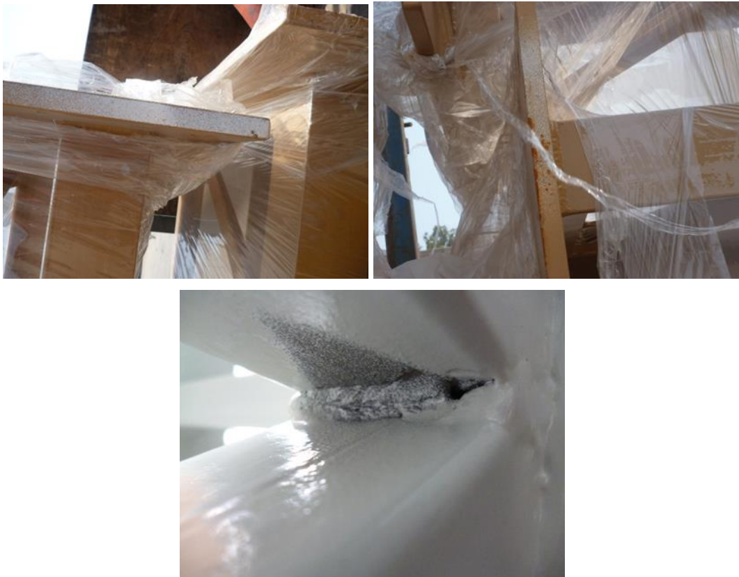
Zonas sin pintura
