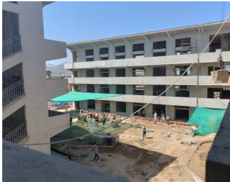
Figura 1: Rehabilitación local escolar N°88106 –Huarmey, Ancash
