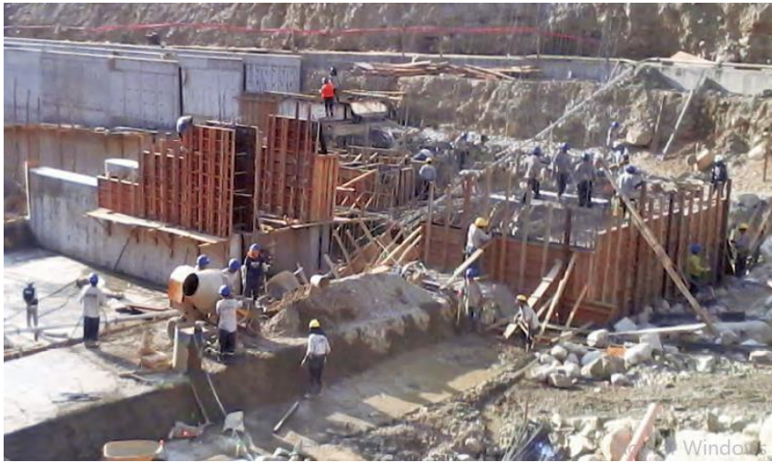
Figura 2: Construcción bocatoma central hidroeléctrica Santa Cruz, Ancash
