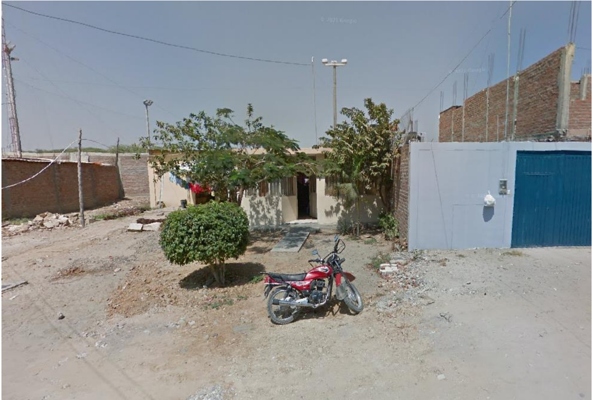
Anexo N°8.- Estado de la vivienda en el año 2016 Fuente: Fotografía de la vivienda en el año 2016
