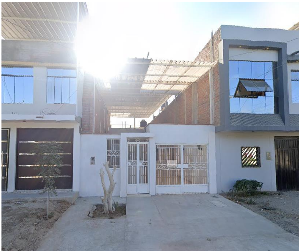
Anexo N°9.- Estado de la vivienda en el año 2022 Fuente: Fotografía de la vivienda en el año 2022
