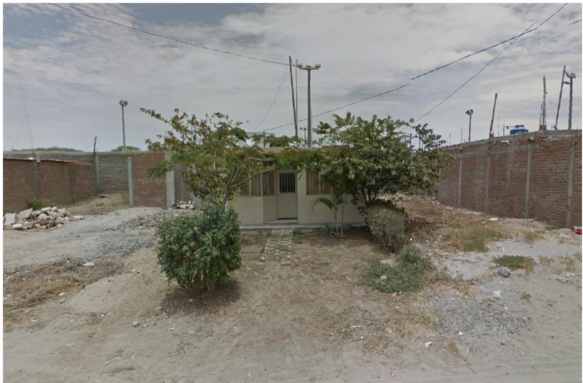
Anexo N°7.- Estado de la vivienda en el año 2013 Fuente: Fotografía de la vivienda en el año 2013
