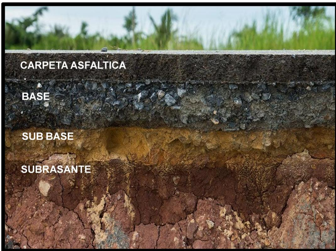
**Figura 2.** Corte transversal de pavimentos flexible.
