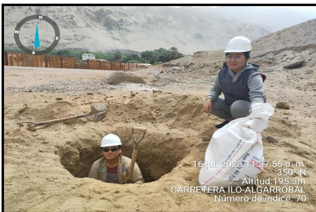
**Figura 12.** Toma de muestra del suelo (Calicata N°03) Km 2+760.
