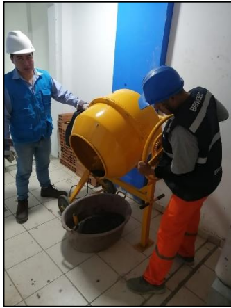
Foto13. Personas de la mezcla de concreto
