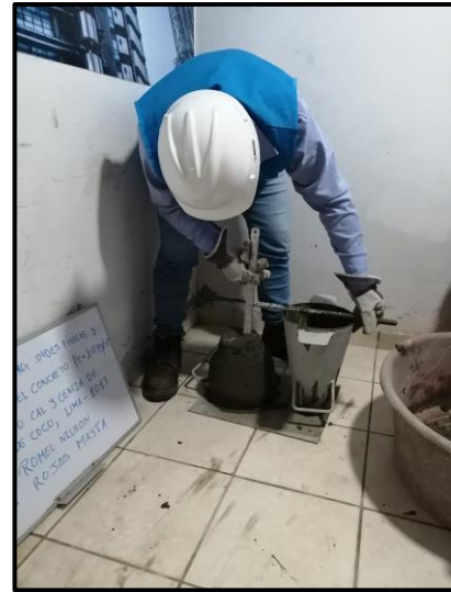
Figura 26. Medición de Asentamiento del concreto fresco
