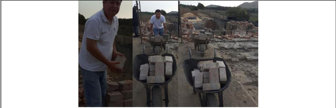
Fotografía 10. Obtención de los ladrillos cocidos
