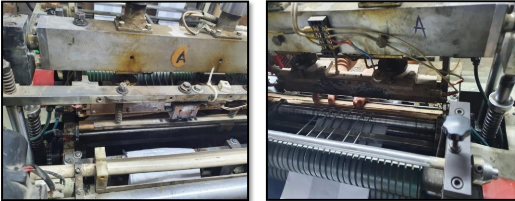
Figura 18. Fusibles en mal estado
