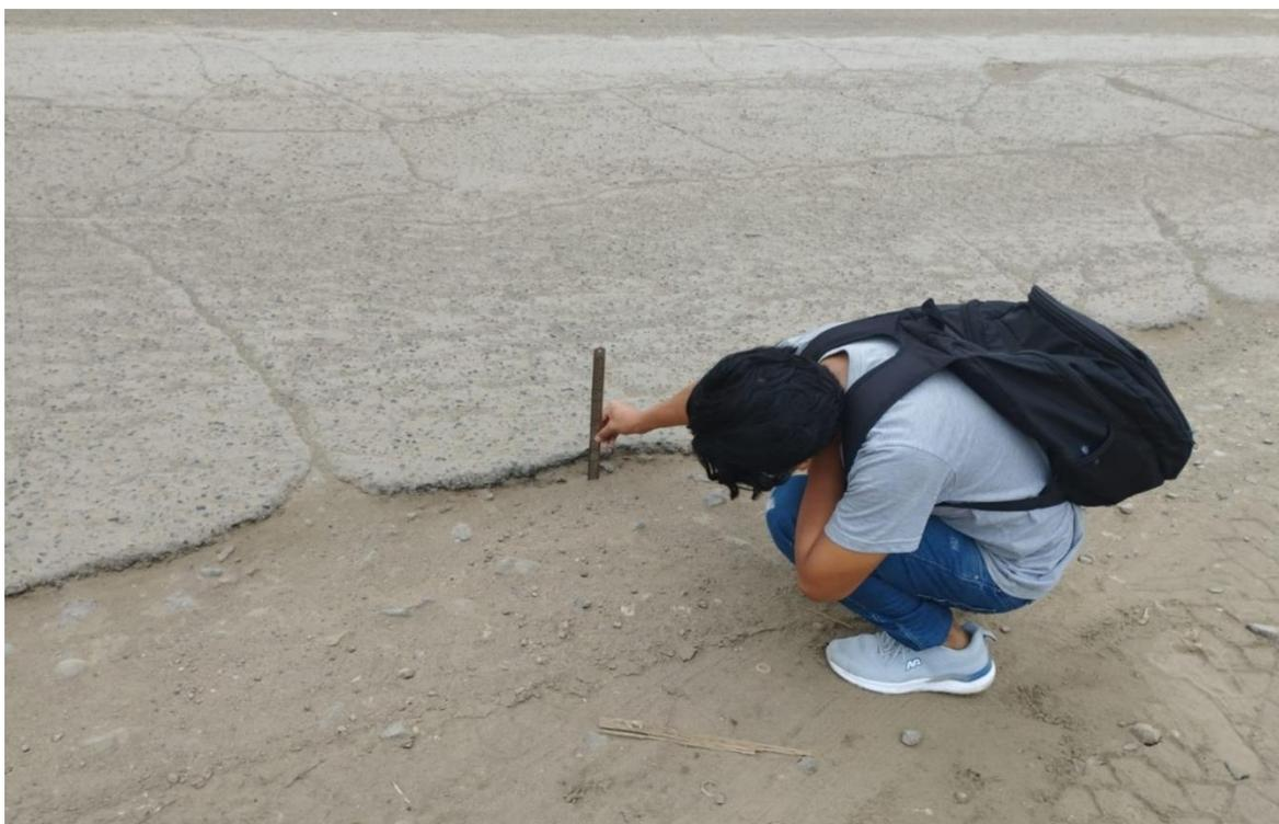
ANEXO 111: Identificación de las fallas por desprendimiento de agregas y grieta de borde
