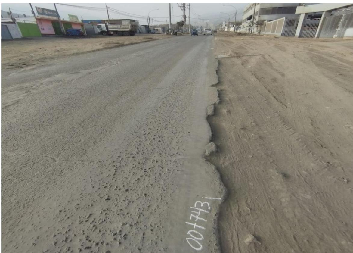
ANEXO 112: Identificación de las fallas por desprendimiento de agregados
