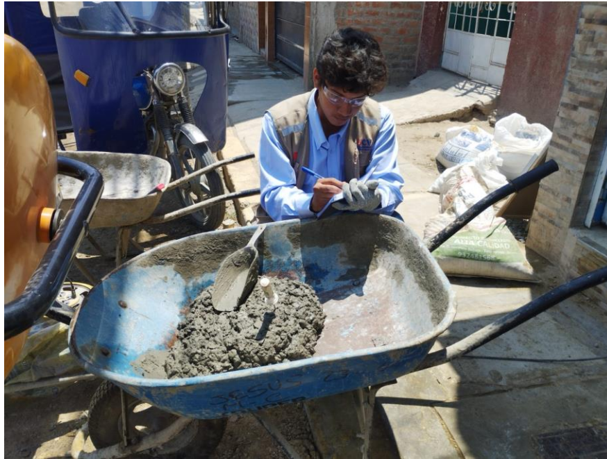
FOTO 12: REGISTRO DE TEMPERATURA AMBIENTE Y DEL CONCRETO
