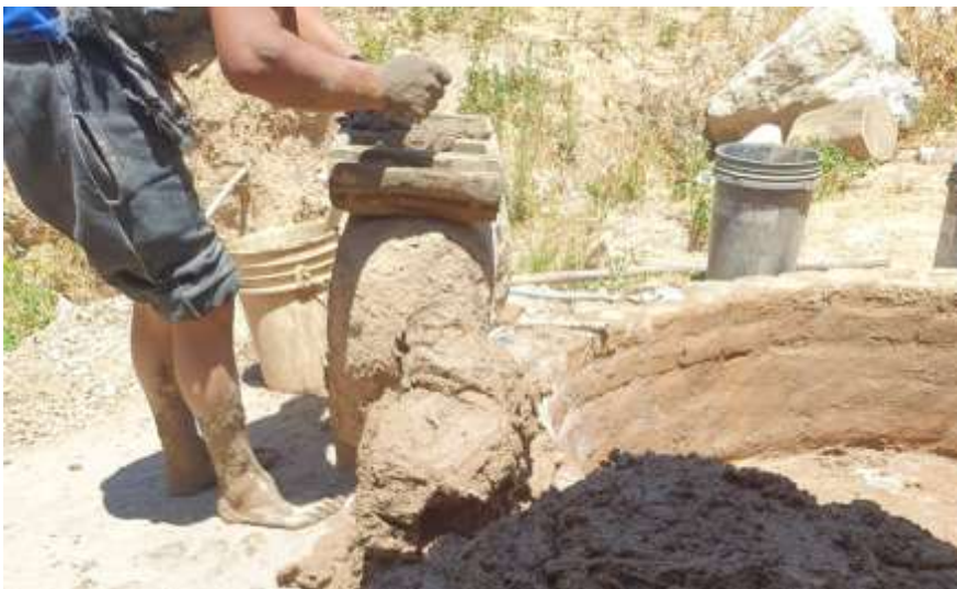
Figura 8: Moldeando el ladrillo arcilla + ceniza
