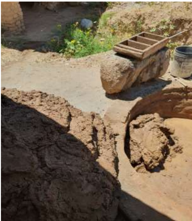
Figura 4: Mortero de arcilla
