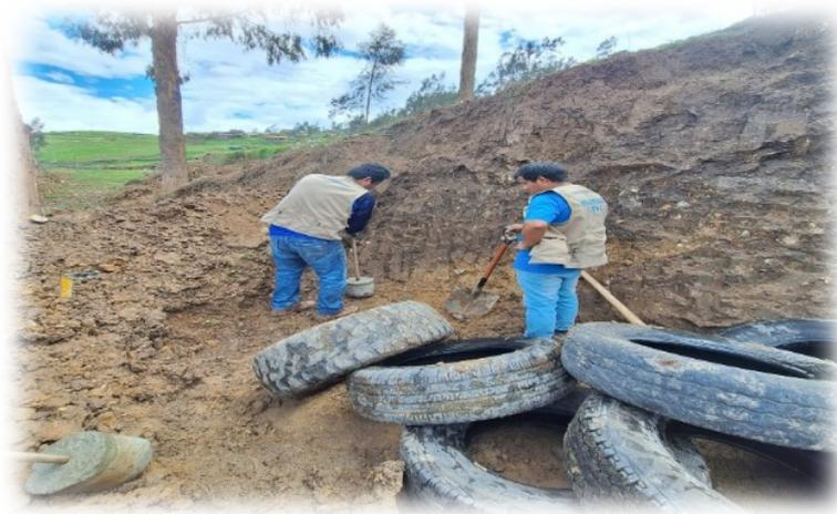
Fig. Se procedió a la compactación para la colocación de las llantas.
