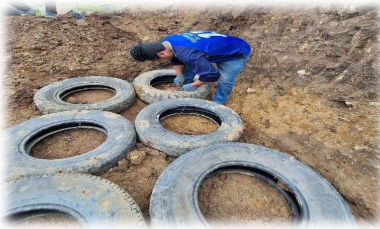
Fig. Las llantas fueron amarradas con alambres galvanizados para su mayor resistencia.
