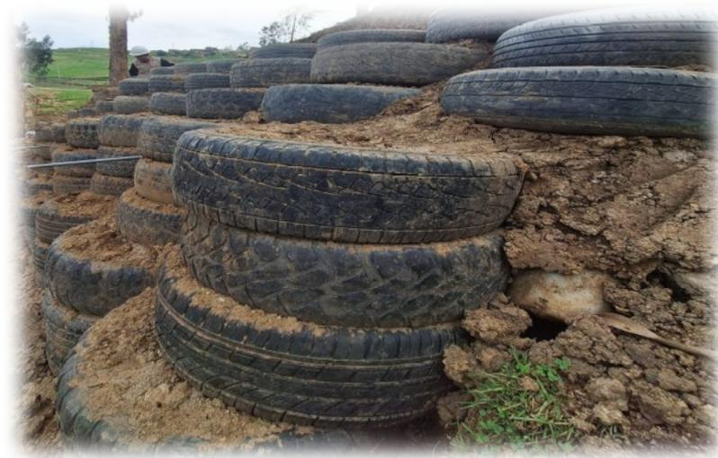
Fig. Evidencia de la construcción del muro a base de llantas recicladas.
