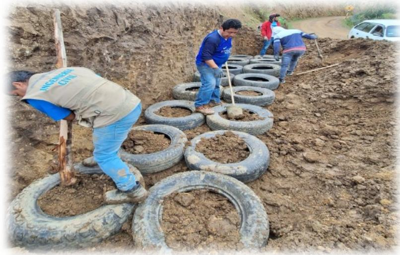
Fig. Se acomodó las llantas y se rellenó con material propio del lugar.
