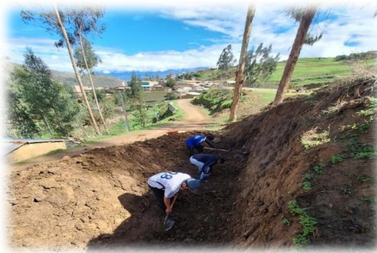
Fig. Excavación del terreno de 50 cm de profundidad en el tramo Mataquita.
