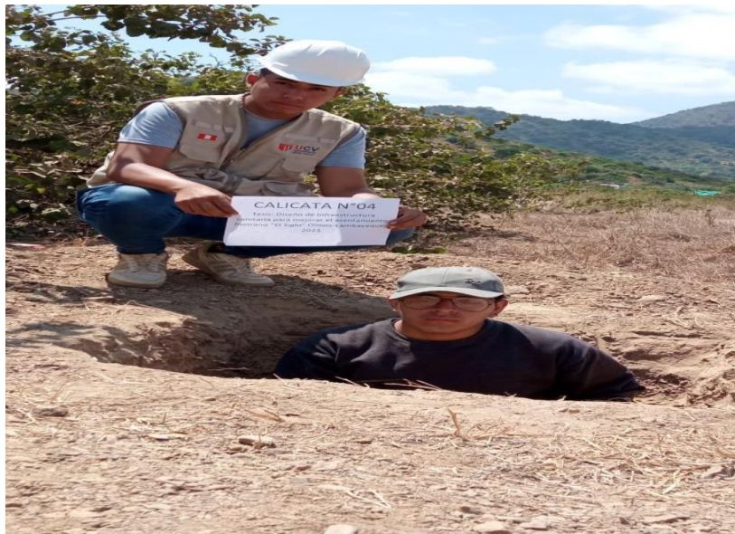
Figura 12. El Siglo: Calicata N°4, por excavación manual, 2023. Fuente: elaboración propia.
