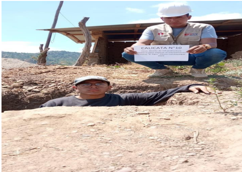
Figura 17. El Siglo: Calicata N°10, por excavación manual, 2023. Fuente: elaboración propia.
