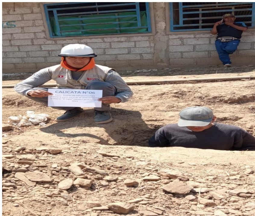
Figura 14. El Siglo: Calicata N°6, por excavación manual, 2023. Fuente: elaboración propia.
