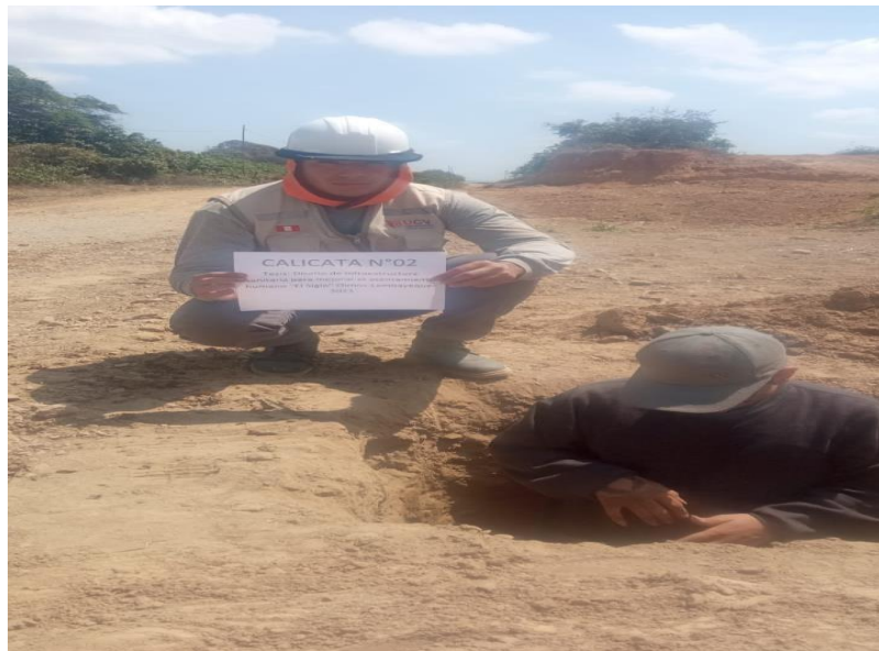
Figura 10. El Siglo: Calicata N°2, por excavación manual, 2023. Fuente: elaboración propia.
