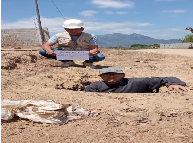
Figura 15. El Siglo: Calicata N°7, por excavación manual, 2023. Fuente: elaboración propia.
