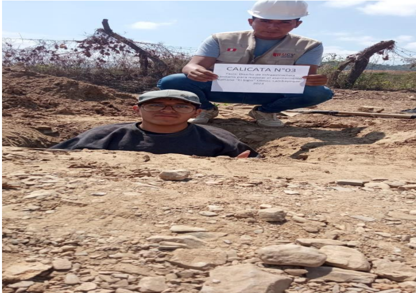
Figura 11. El Siglo: Calicata N°3, por excavación manual, 2023. Fuente: elaboración propia.
