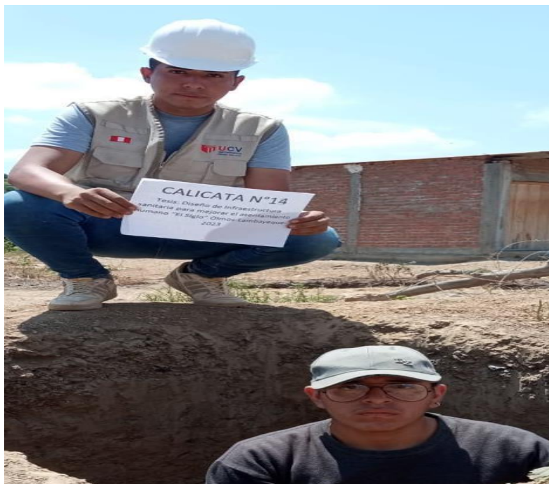
Figura 20. El Siglo: Calicata N°14, por excavación manual, 2023. Fuente: elaboración propia.
