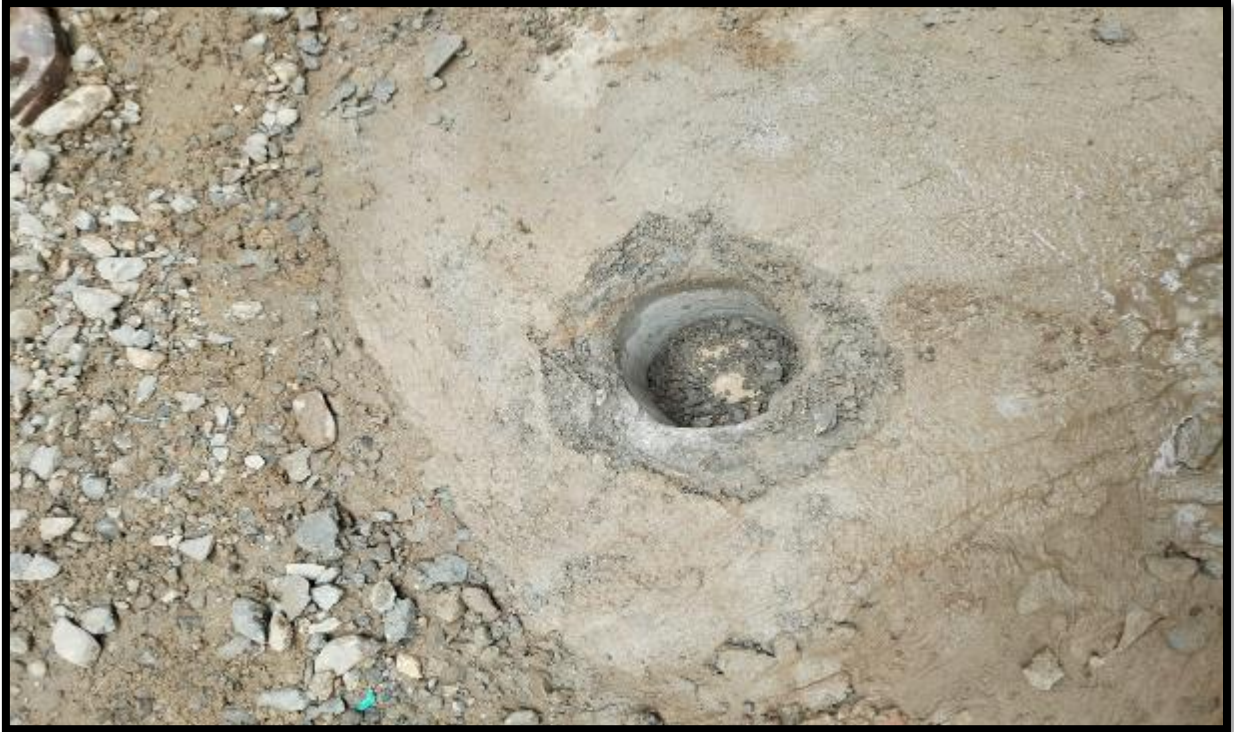
Foto 69. Extracción de la muestra de concreto con adición de AM a los 50 días de vaciado al paño de losa.
