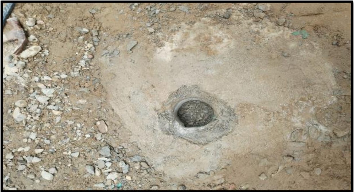
Foto 70. Paño de losa de concreto con la muestra extraída para su posterior ruptura a compresión.
