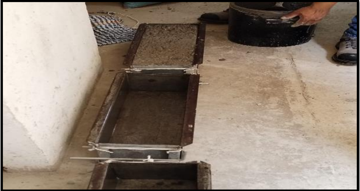
Foto 25. Preparación de los moldes tipo viga para el vaciado de concreto con adición de AM.
