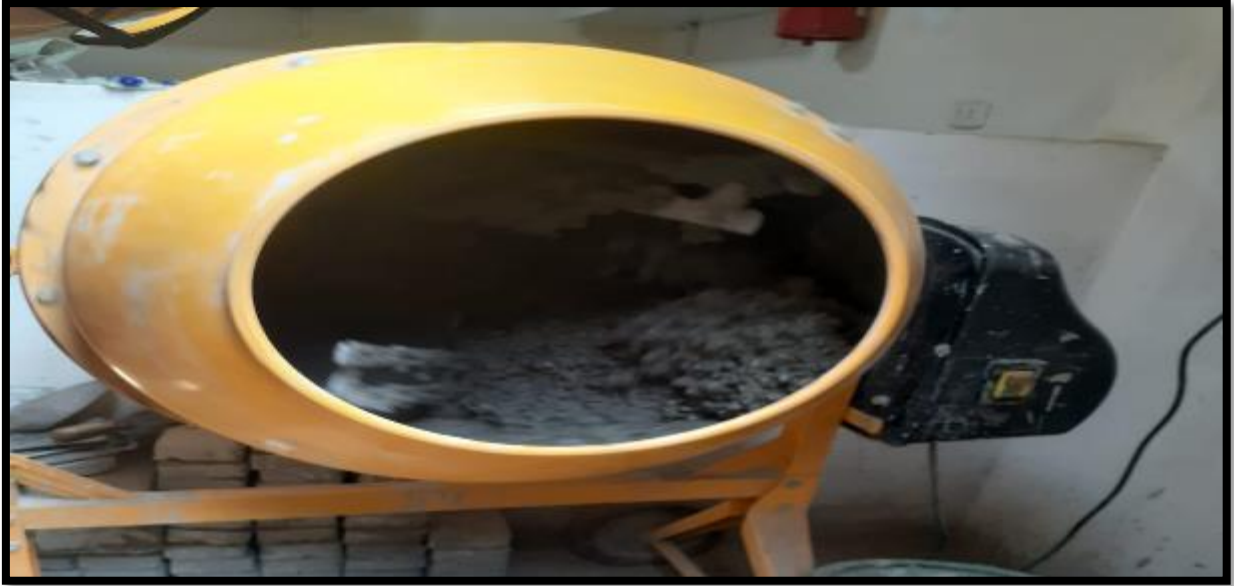
Foto 07. Mezcla de concreto control en el trompo mecánico para su correcto mezclado de todos los elementos.
