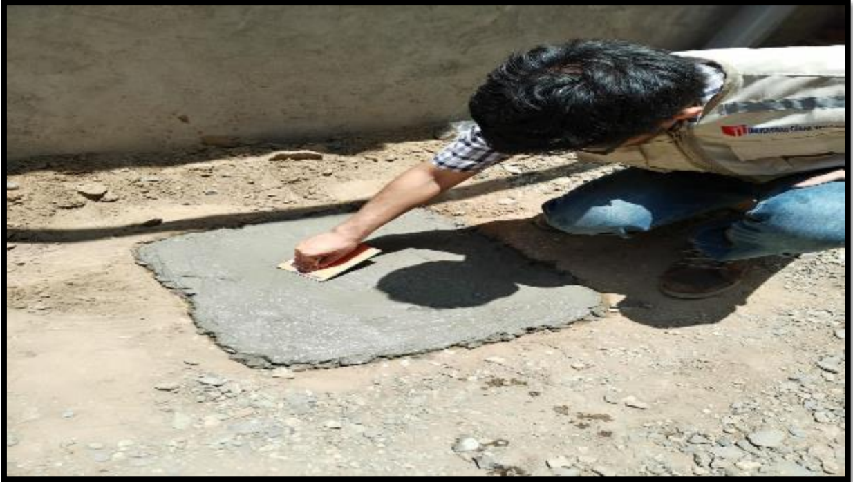
Foto 57. Tesista Villarroel Cieza Marlon enluciendo el paño de losa de concreto.
