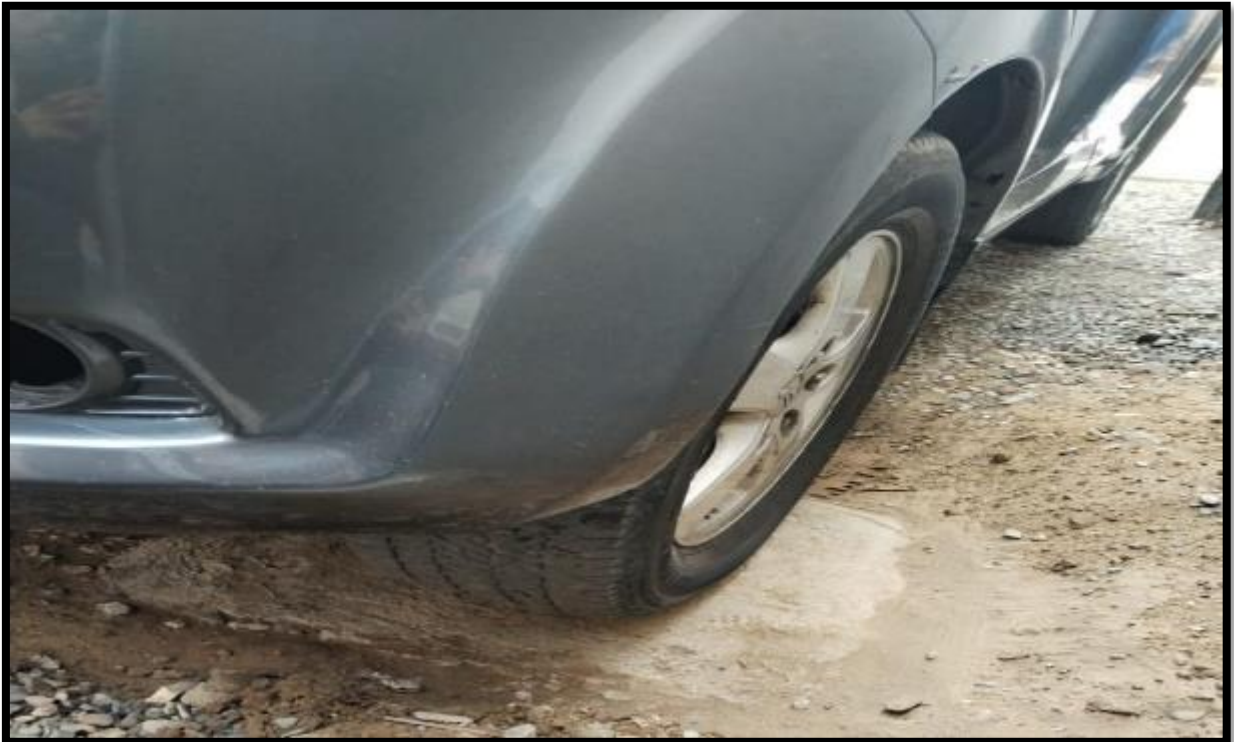
Foto 60. Peso del vehículo uno en el paño de la losa de concreto con adición de AM.
