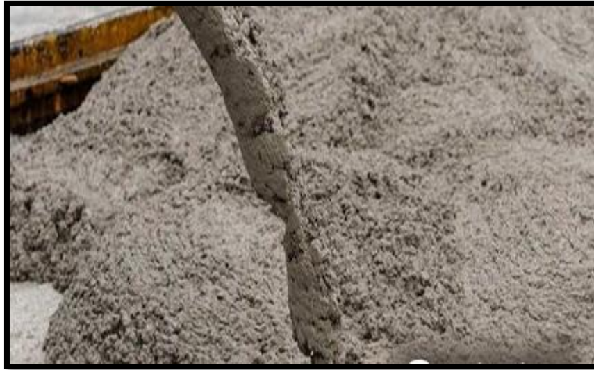
Figura 6. Concreto en estado líquido.
