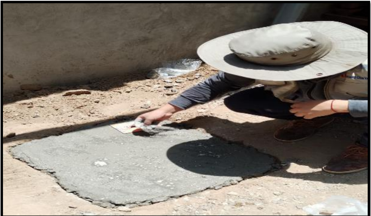
Foto 56. Acabado final del paño de losa de concreto con adición de AM al 5.00% para ser sometido a cargas y condiciones desfavorables.
