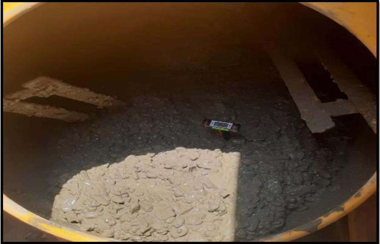
Foto 19. Medición de la temperatura de la mezcla de concreto control.
