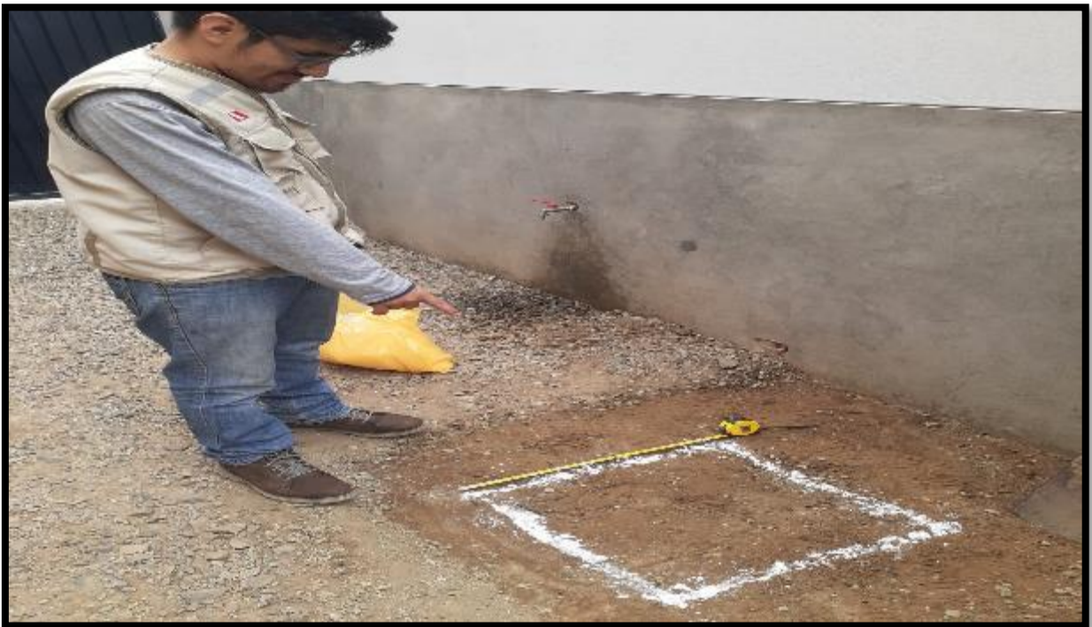
Foto 54. Tesista Villarroel Cieza Marlon señalando el paño de losa a realizar.
