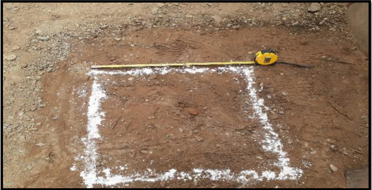
Foto 53. Medición de la losa de concreto para el vaciado de la mezcla con AM al 5.00%.
