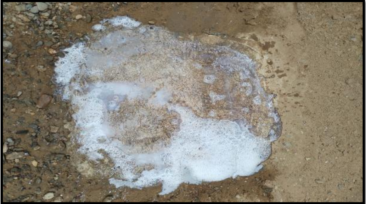
Foto 67. Paño de losa de concreto con adición de AM sometido a ataques químicos, en diferente día, simulando una losa destinada a lavado de vehículos.
