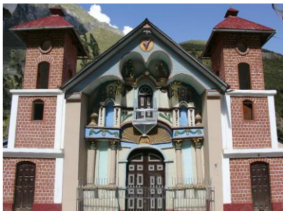
Fuente: Registro fotográfico propio Figura 9. Iglesia colonial san Bartolomé de Picoy
