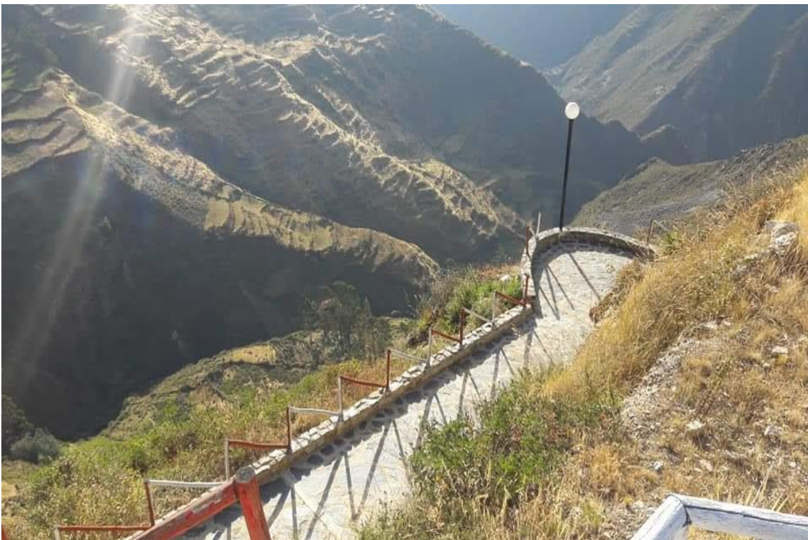
Figura 29: Entrada al Mirador San Cristóbal
