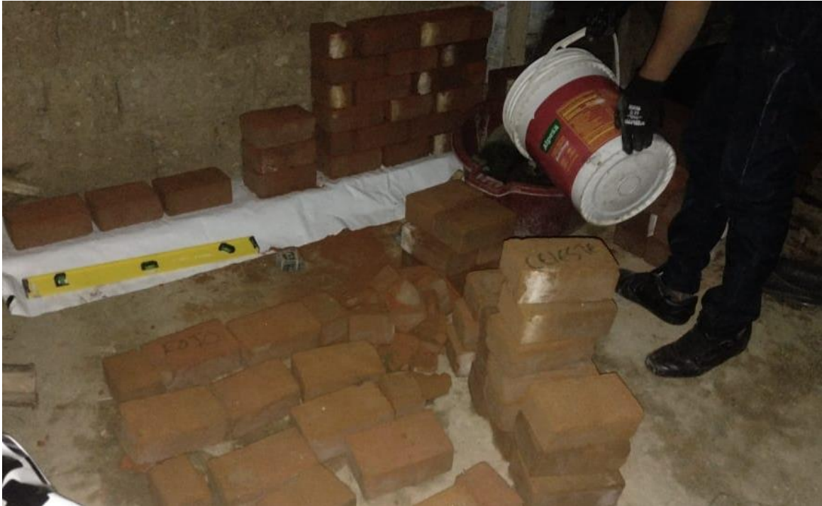
Proceso constructivo de las muestras.
