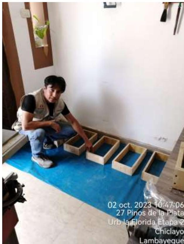
Imagen. Armado de moldes
