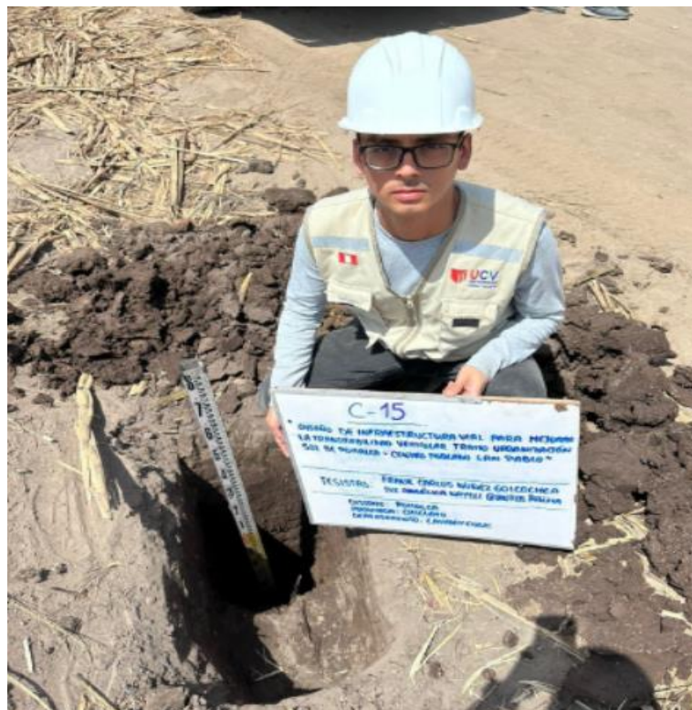
Figura 30. Excavación de calicata N° 15. Fuente: elaboración propia.
