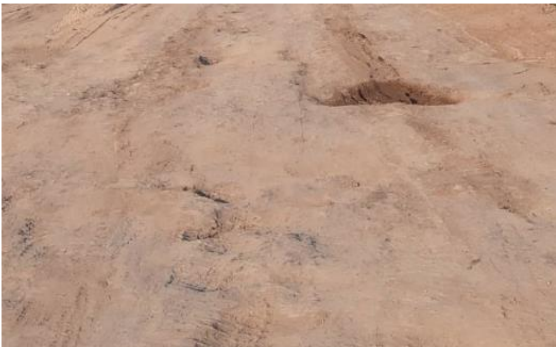
Figura 8. Bacheo en tramo de la ruta.
