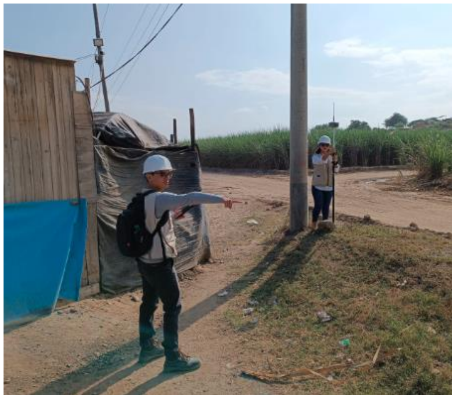
Figura 17. Toma de Punto, BM N° 01– camino a Centro Poblado San Pablo.
