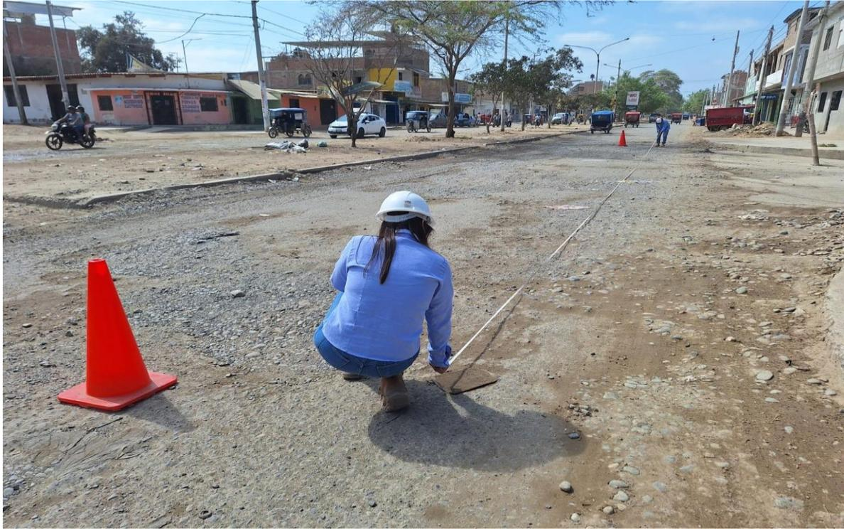
Figura 27. Desprendimiento de agregados
