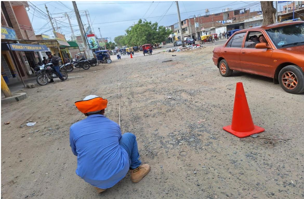
Figura 18. Perdida de agregados
