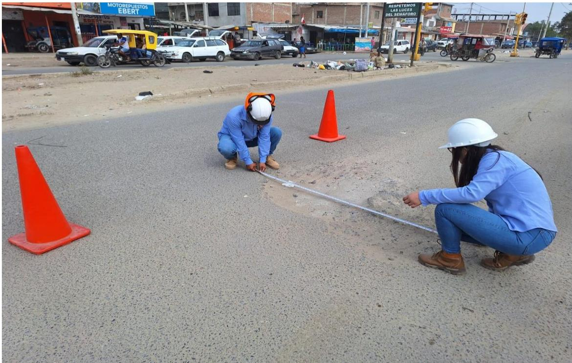
Figura 22. Grietas en el paso de las ruedas
