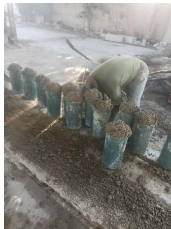
Fotografía 24: Elaboración de las probetas Fuente: La empresa
