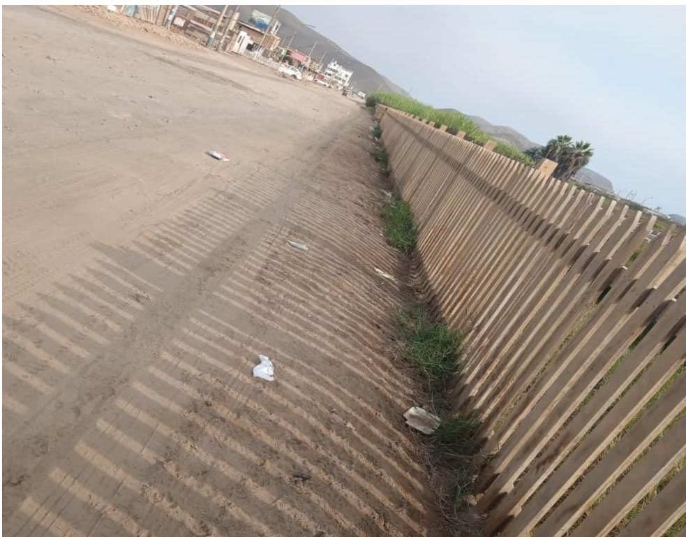
Figura 3 vista de la avenida principal que da acceso al humedal estado actual
