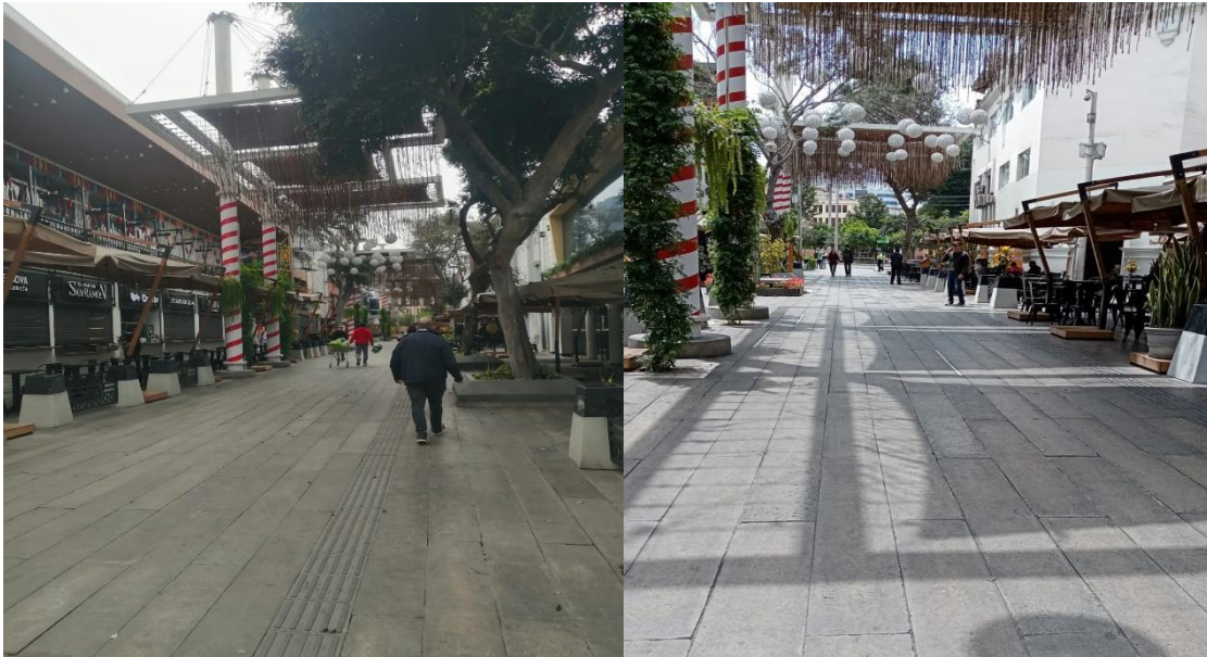
Figura 3. Rehabilitación de la Ex calle las Pizzas, hoy en días llamado pasaje San Ramón
