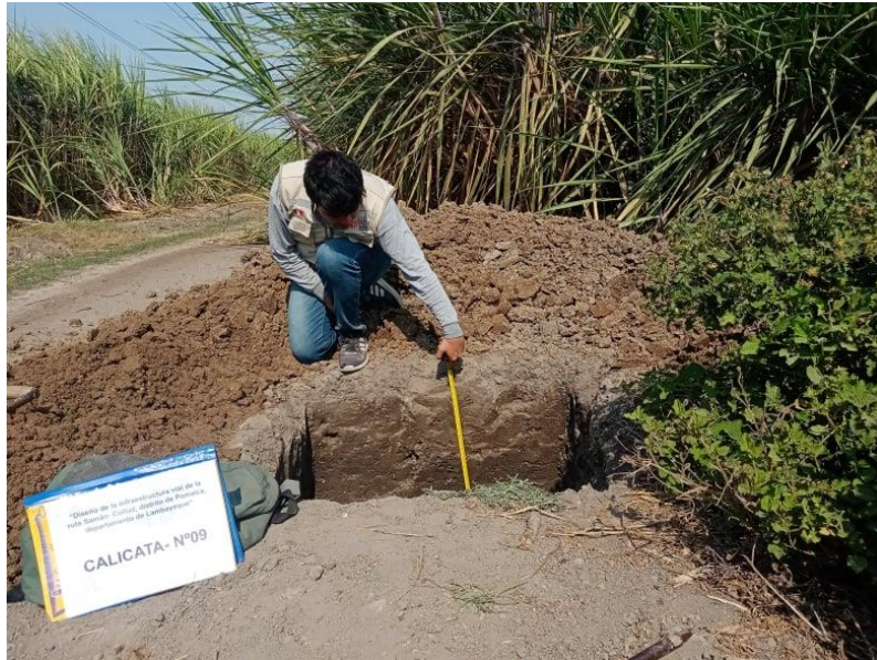
Figura 22. Excavación de la calicata N°09 a una profundidad de 1.50m. Fuente: Elaboración propia
