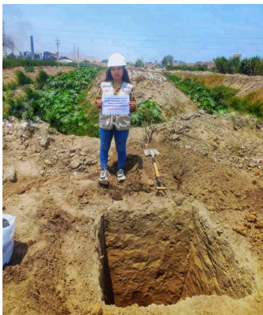
Figura 24. Excavación de la calicatas N°12 a una profundidad de 1.50m.
