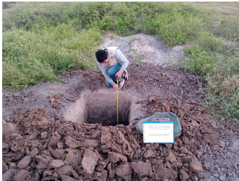
Figura 21. Excavación de la calicata 07 a una profundidad de 1.50 m.
