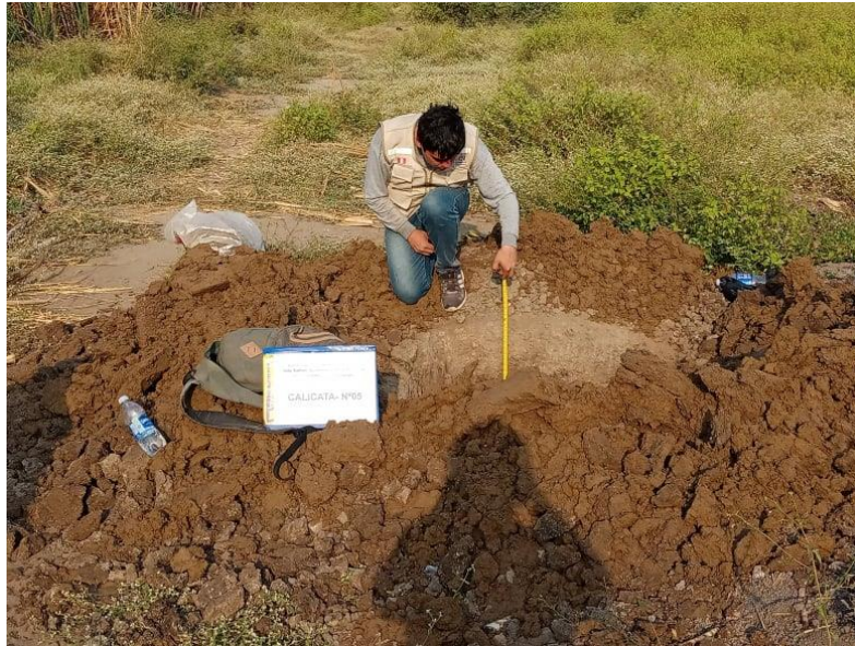
Figura 20. Excavación de la calicata 05 a una profundidad de 1.50 m.
