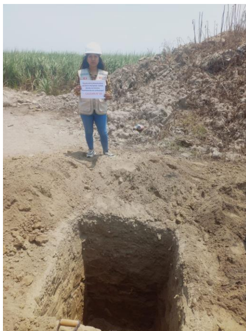
Figura 25. Excavación de la calicatas N°13 a una profundidad de 1.50m.
