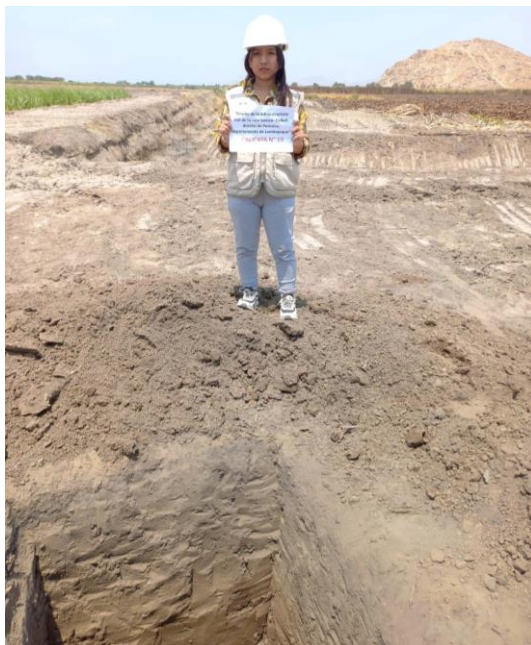
Figura 28. Excavación de la calicata N°19 a una profundidad de 1.50m.
