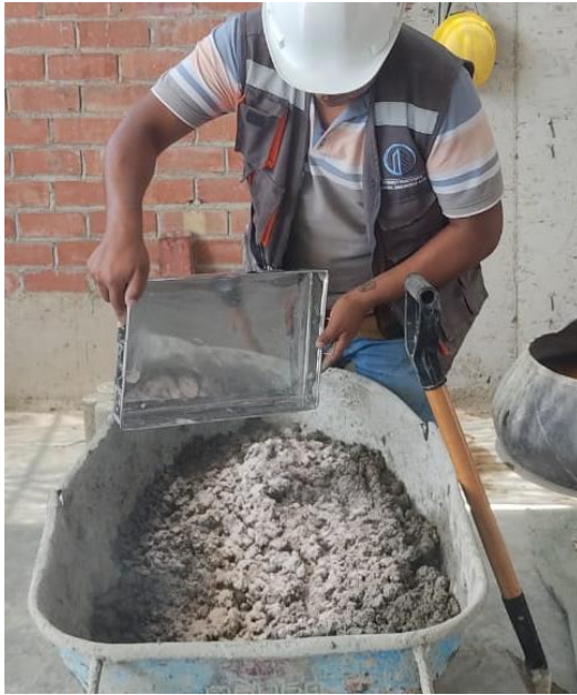
Figura 10. Mezcla de concreto
