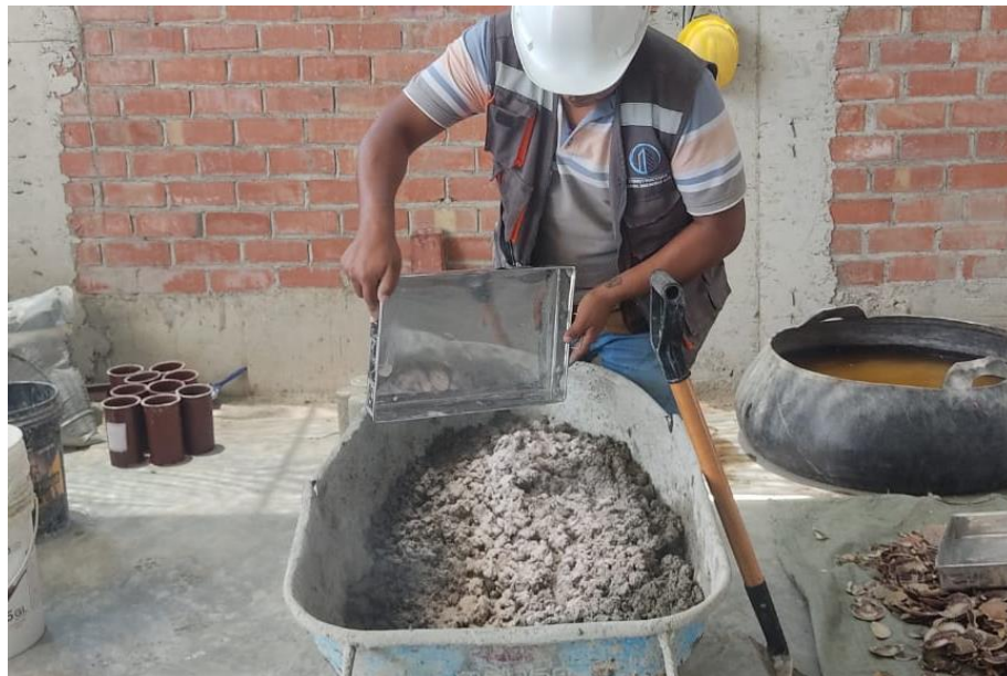
Figura 09. Preparación de la mezcla de concreto con adición de polvo de concha de abanico.
