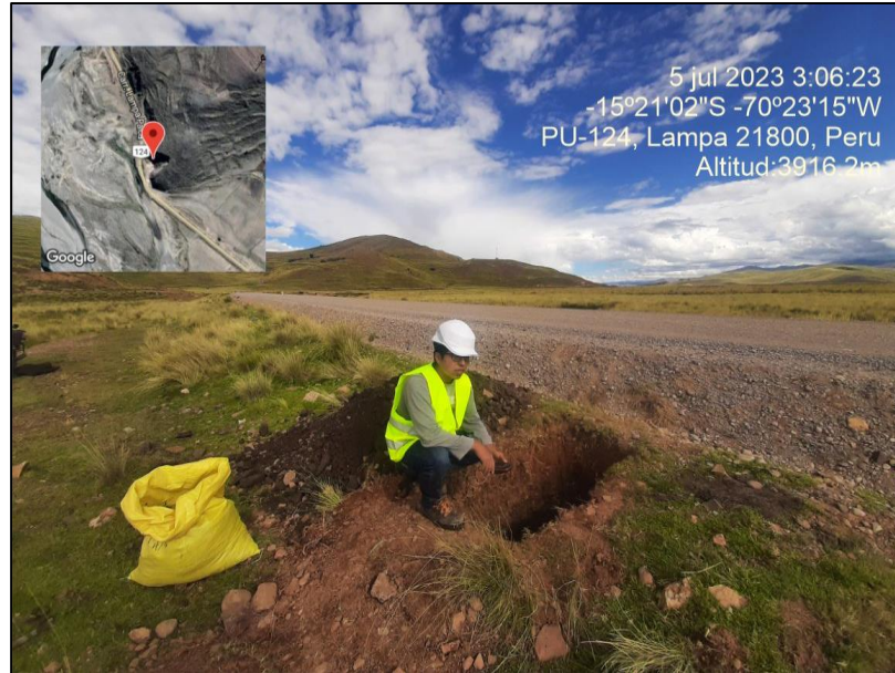
Figura 07: Excavación de la calicata C-1 (km 1+000)
