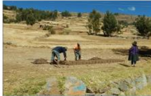
Fabricación del adobe en base de tierra, paja.
