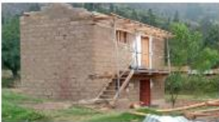
Vista de una vivienda en construcción que posee una técnica ancestral.
