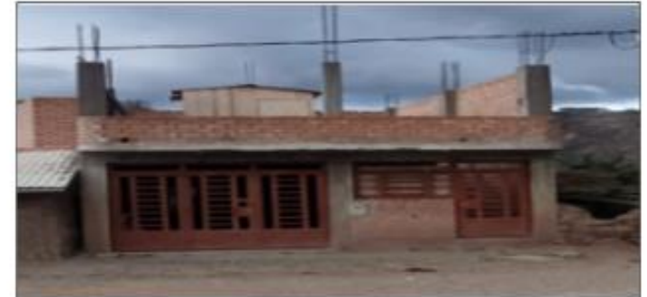
Aplicación de materiales modernos como son el concreto, ladrillo, fierros.
