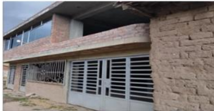
Vivienda basada en material de adobe.
