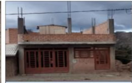
vista panorámica de una vivienda en construcción con materiales moderna.
