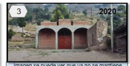
3 2020 Imagen se puede ver que ya no se mantiene el diseño anterior podemos ver una construcción moderna con una nave central y a sus laterales también, columnas circulares, construido con material noble, puerta de metal color marrón.
