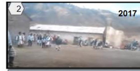
2 2017 Imagen se puede observar que se ha demolido la construcción de material de adobe para que puedan construir el local comunal del centro poblado.
