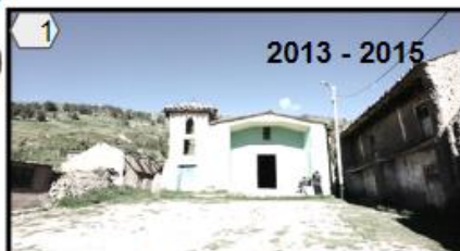
1 2013 - 2015 Imagen se puede observar la iglesia con una torre con su campana al lado derecho, techo a dos aguas, puerta de 3.00 m, fachada pintada de color verde, con construcción de adobe se puede ver que es tradicional.
