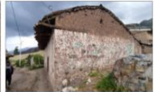
Vista lateral de una vivienda de color blanco
