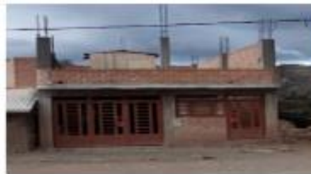
Vista panorámica, de una vivienda constituida por técnica moderna.
