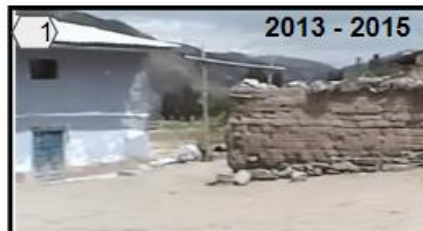
1 2013 - 2015 Se puede ver una vivienda de adobe de pintado de color azul con techo a dos aguas con teja de fibrocemento, puerta de color azul, como se puede observar es de 2 pisos.
