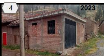
Imagen se puede ver que la vivienda está con una nueva construcción y que ya no se ve la construcción anterior tiene un porton negro de 2.80 de alto con ventanas al costado con material de metal .
