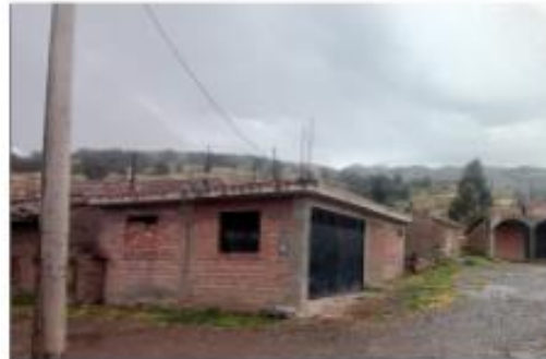
Vista de una vivienda con materiales modernos cemento, ladrillo, fierro.
