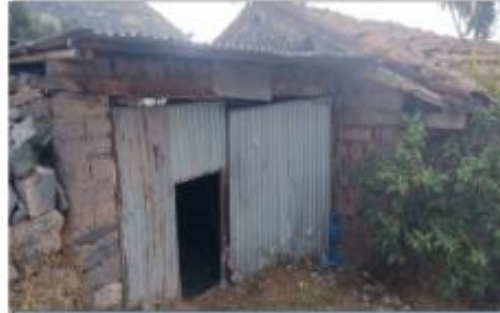
Vista de una puerta de una vivienda basada en construcción vernácula.
