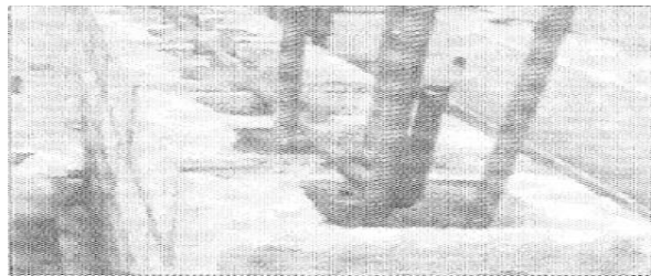
Figura 2: Disposición de los refuerzos en el muro.
