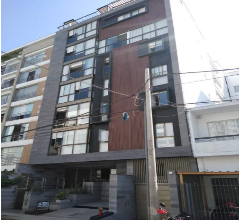
Figura 11. Edificio multifamiliar Fuente Elaboración propia.
